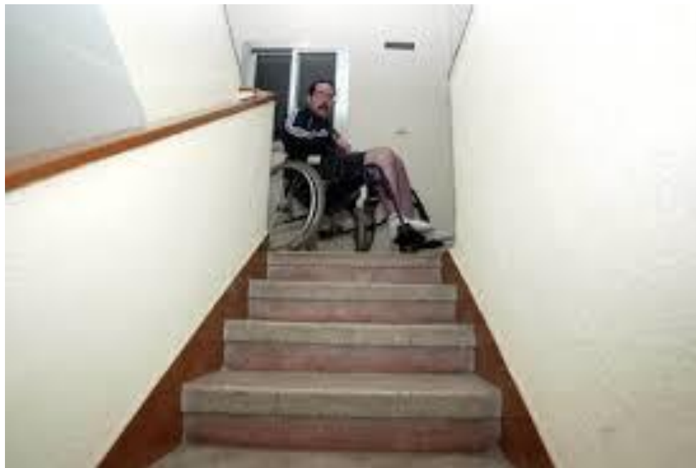
Imagen 1. Escaleras Como principal barrera de Desplazamiento, Fuente propia.
