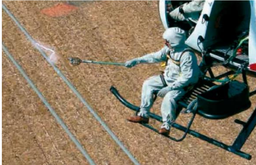
“Figura 2”, ejecución de revisión de torre eléctrica por personal especializado a nivel implementación aéreo.
