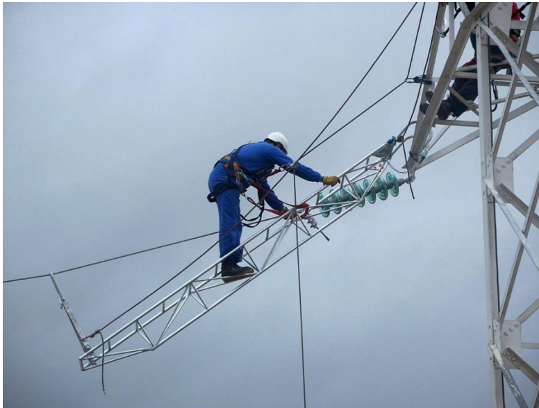
“Figura 1”, ejecución de revisión de torre eléctrica por personal especializado.
