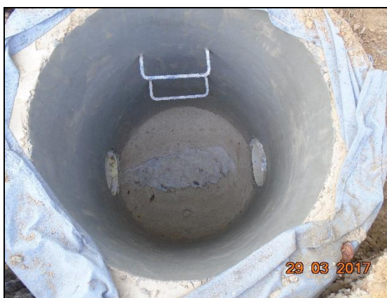
Cavidad interna de una cámara de inspección.
