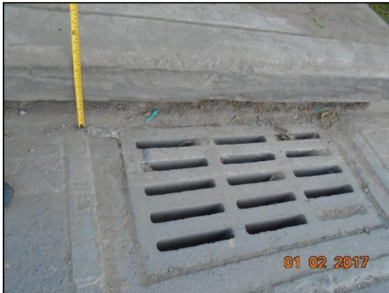
Medidas típicas de los sumideros recolectoras de aguas lluvias.
