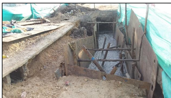
Entibado con madera para facilitar la implementación de tubería de 112
