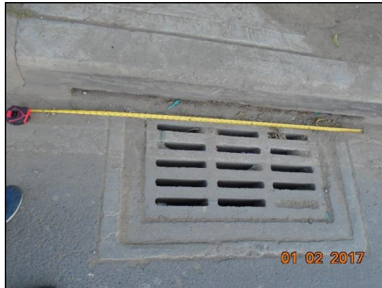
Medidas típicas de los sumideros recolectoras de aguas lluvias.
