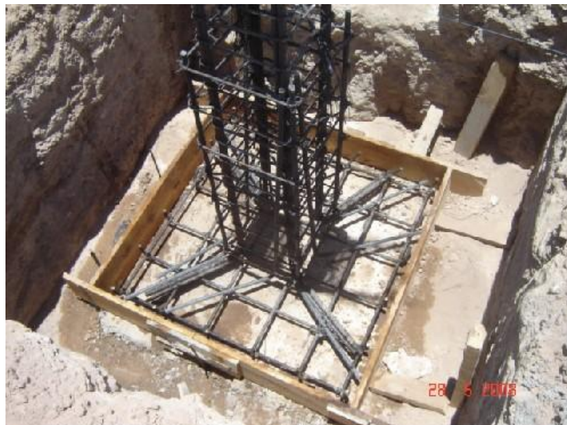
Figura 14: Zapata en concreto
