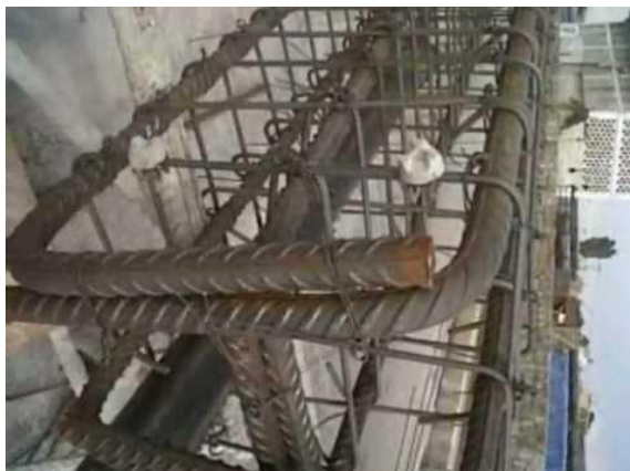
Figura 13: Refuerzo de acero
