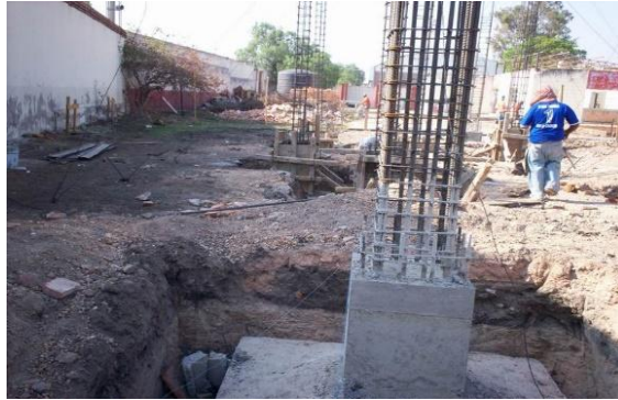
Figura 26: Estructuras en concreto para la cubierta
