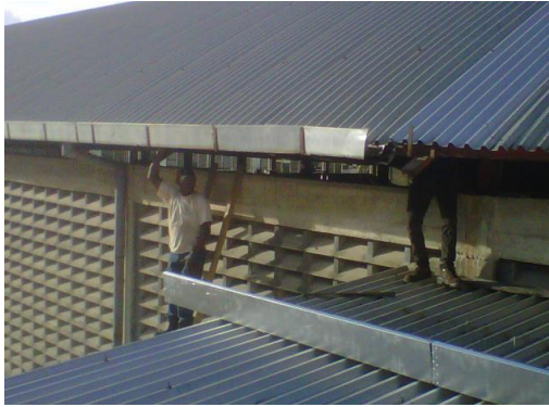
Figura 20 Canal de conducción
