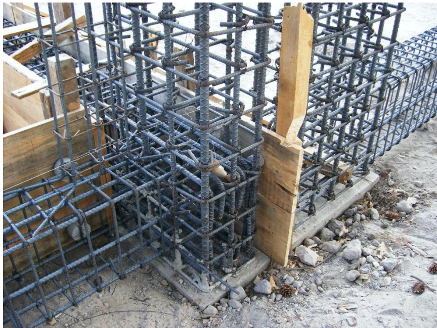
Figura 15: Vigas de amarre
