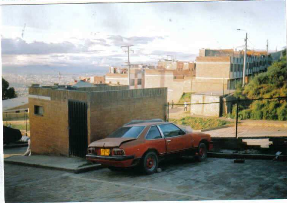
ENTRADA PRINCIPAL A LA URBANIZACIÓN BUENAVISTA ORIENTAL: DESPENSA DE RECOLECCIÓN DE BASURAS Y PARQUEADERO CUMUNAL
