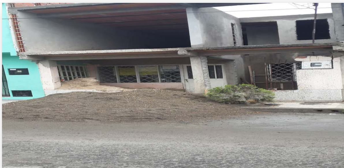
Fotografía 1. Frente de la obra (material de mixto y arena)
