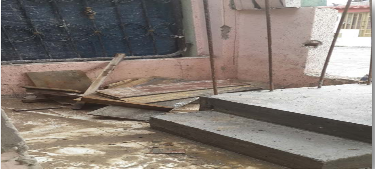
Fotografía 3. Pasillo y escalera exterior.
