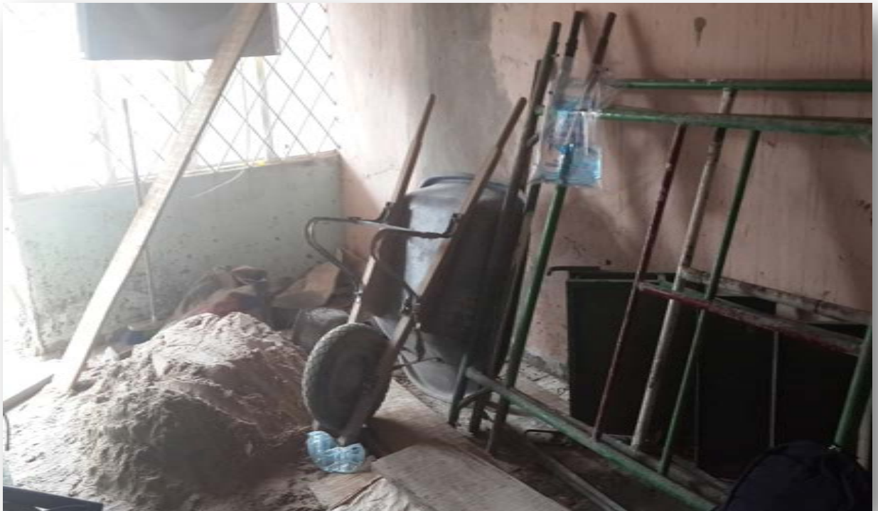
Fotografía 4. Desorden de material y herramientas.
