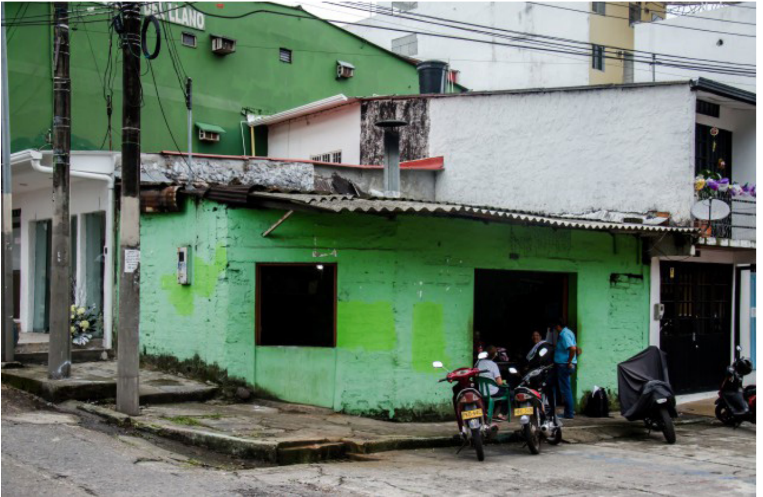
Fotografía 18 : Fachada Taller Herrería familia Torres.
