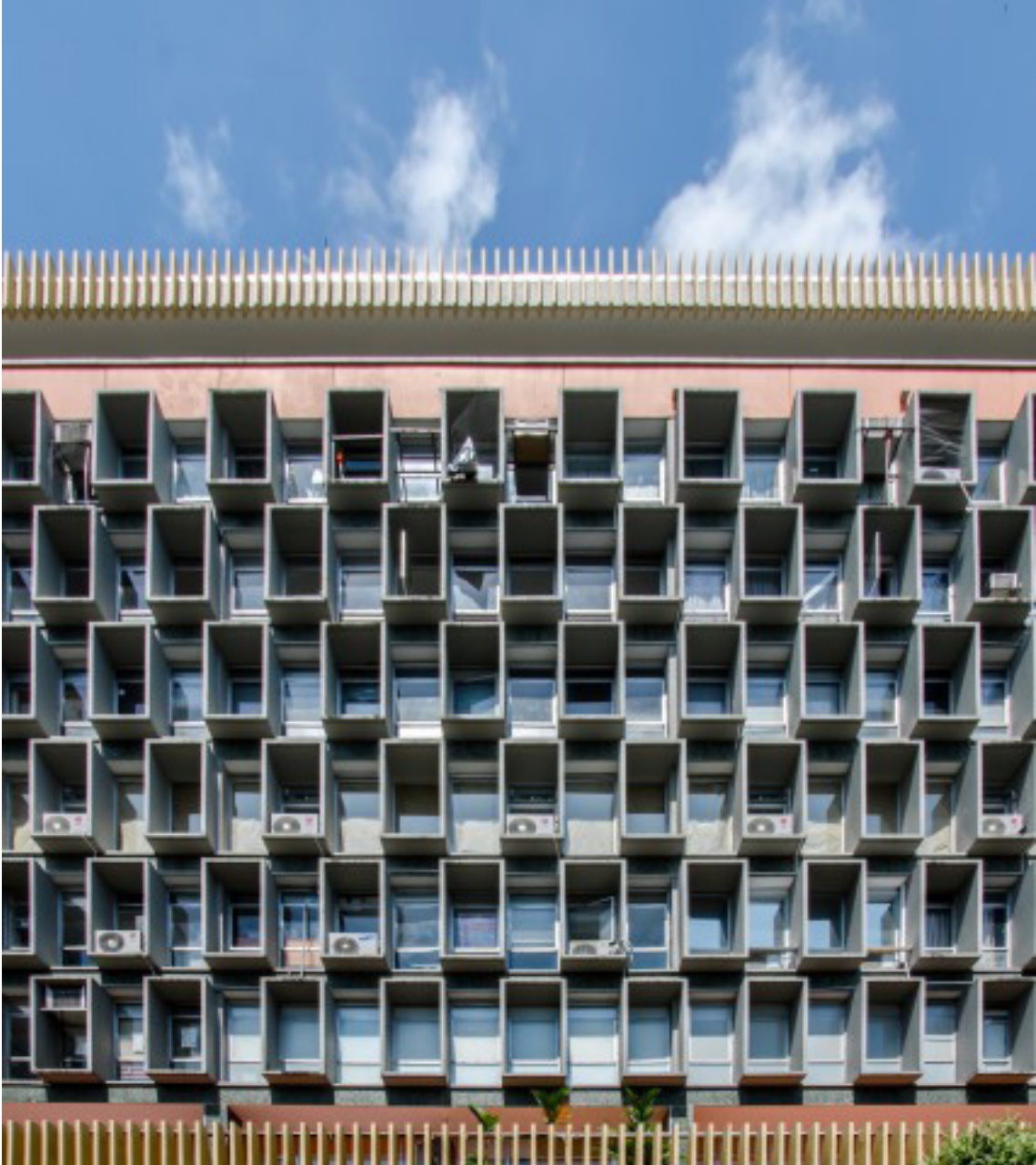
Fotografía 52: Detalle ventanas, Edificio Banco Cafetero y Ganadero.
