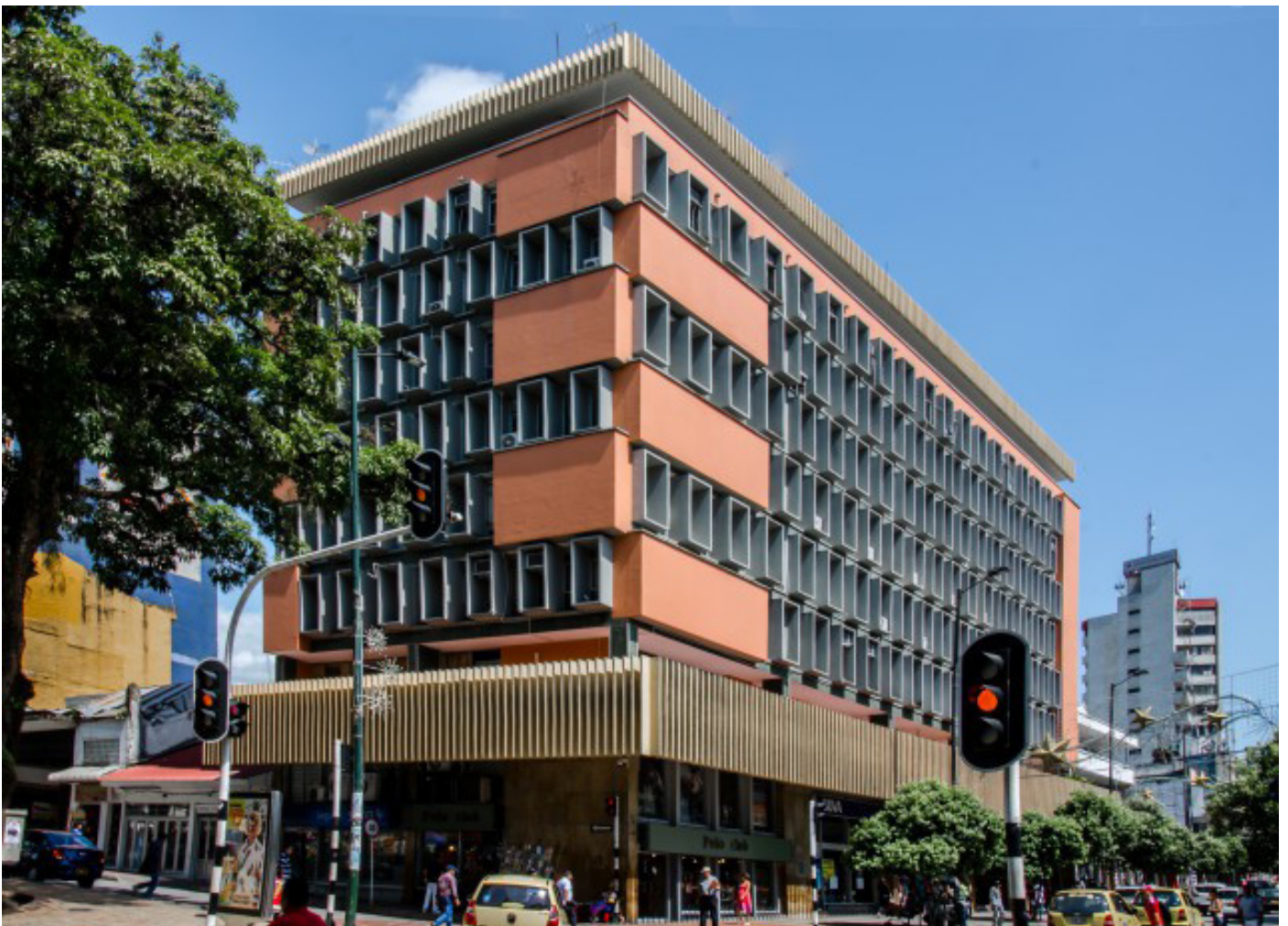
Fotografía 51: Panorámica esquina, Edificio Banco Cafetero y Ganadero.
