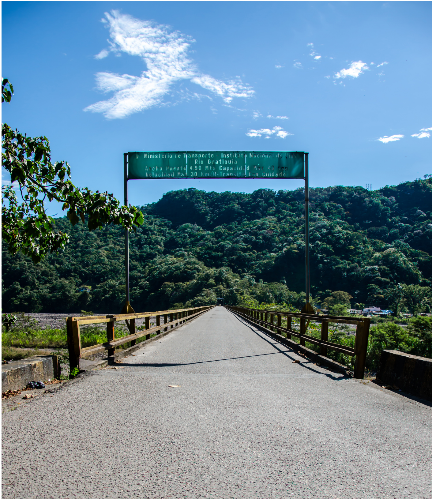
Fotografía 60: Puenete Eduardo Santos.
