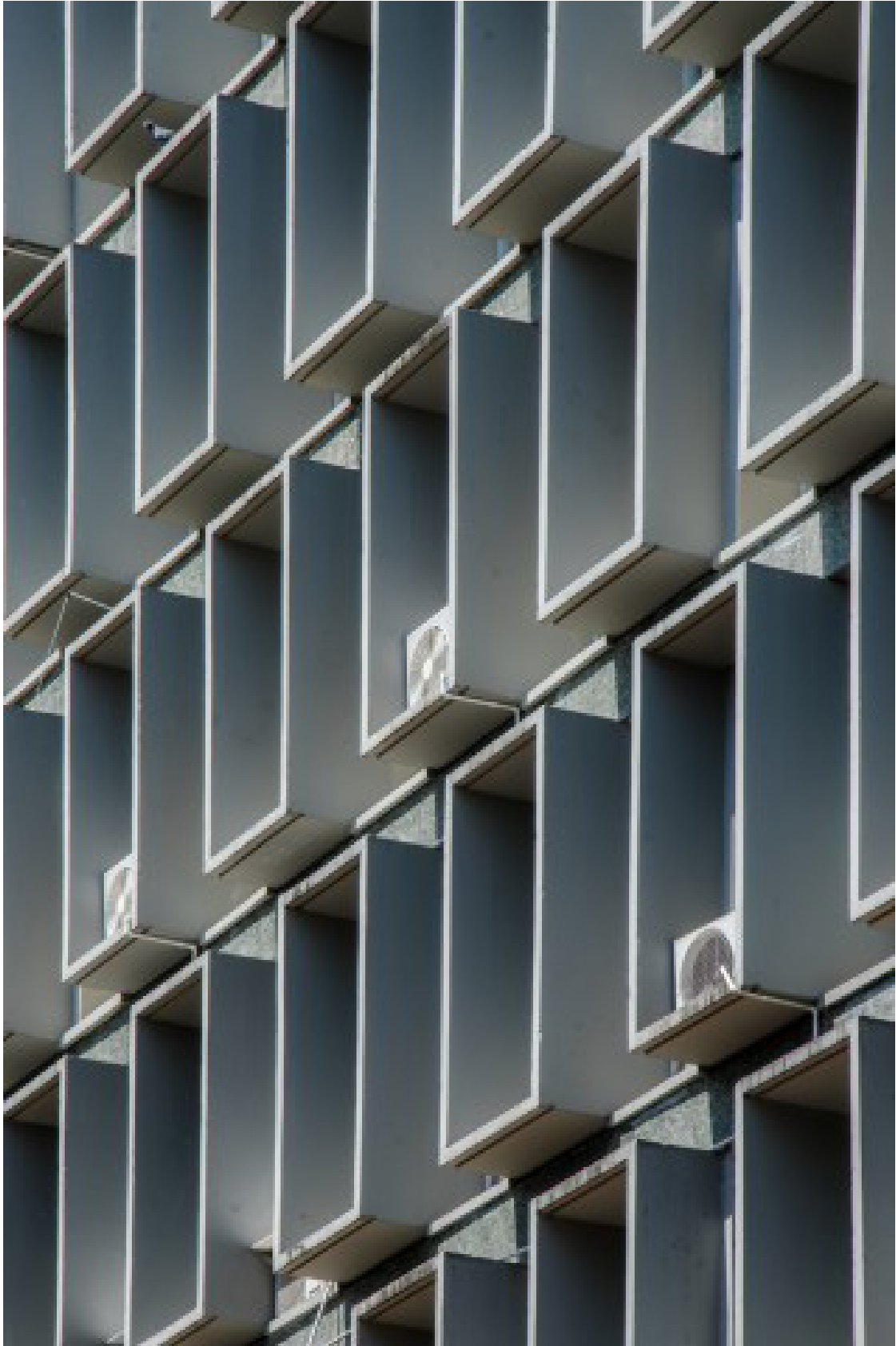
Fotografía 53: Detalle ventanas, Edifició Banco Cafetero y Ganadero.
