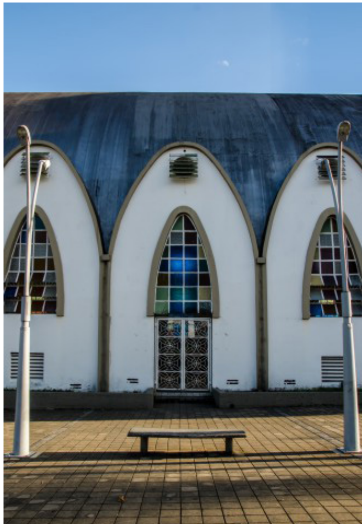
Fotografía 34: Detalle entrada lateral y ventanales, Iglesia Eucarística del Templete.
