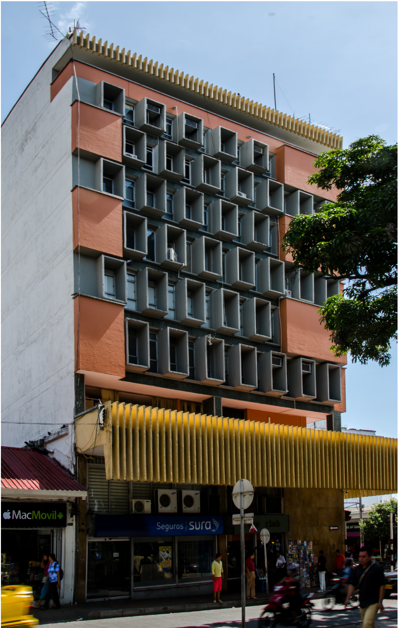
Fotografía 49: Lateral, Edificio Banco Cafetero y Ganadero.
