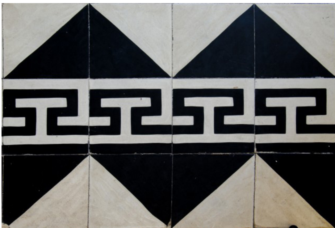
Fotografía 16: Detalle baldosa 03, Interior casa Señora Felicidad Barrios.
