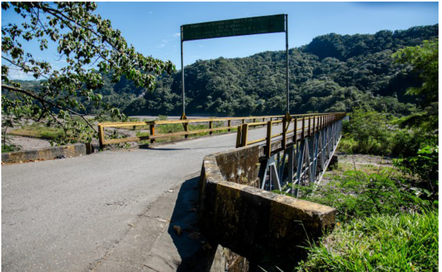
Fotografía 63: Puenete Eduardo Santos.
