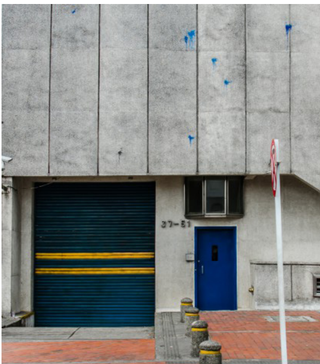
Fotografía 44: Detalle lateral, Edificio Banco de la República.
