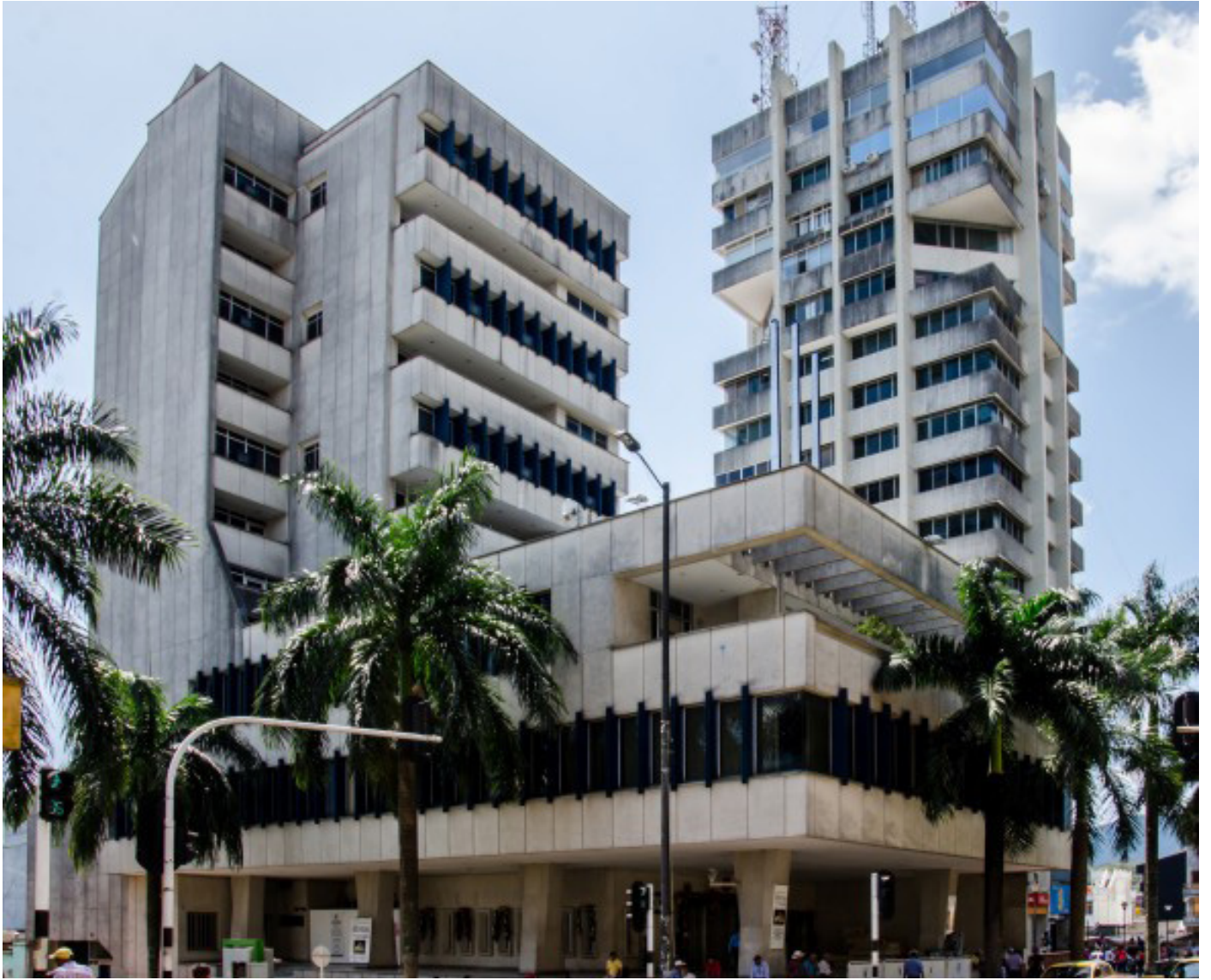
Fotografía 43: Edificio Banco de la República.
