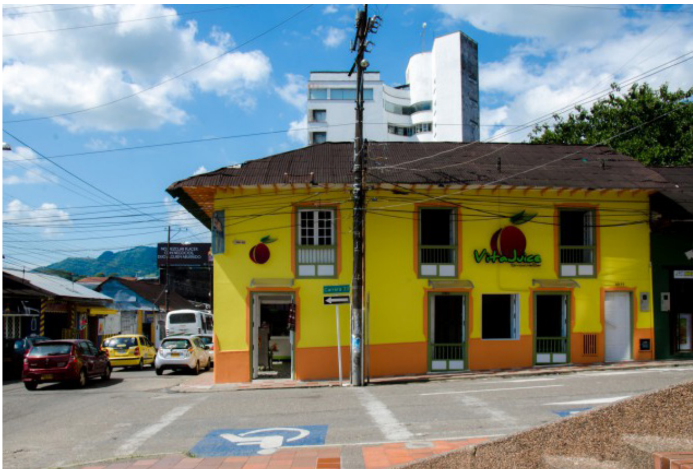
Fotografía 06: Fachada casa Jairo Miranda
