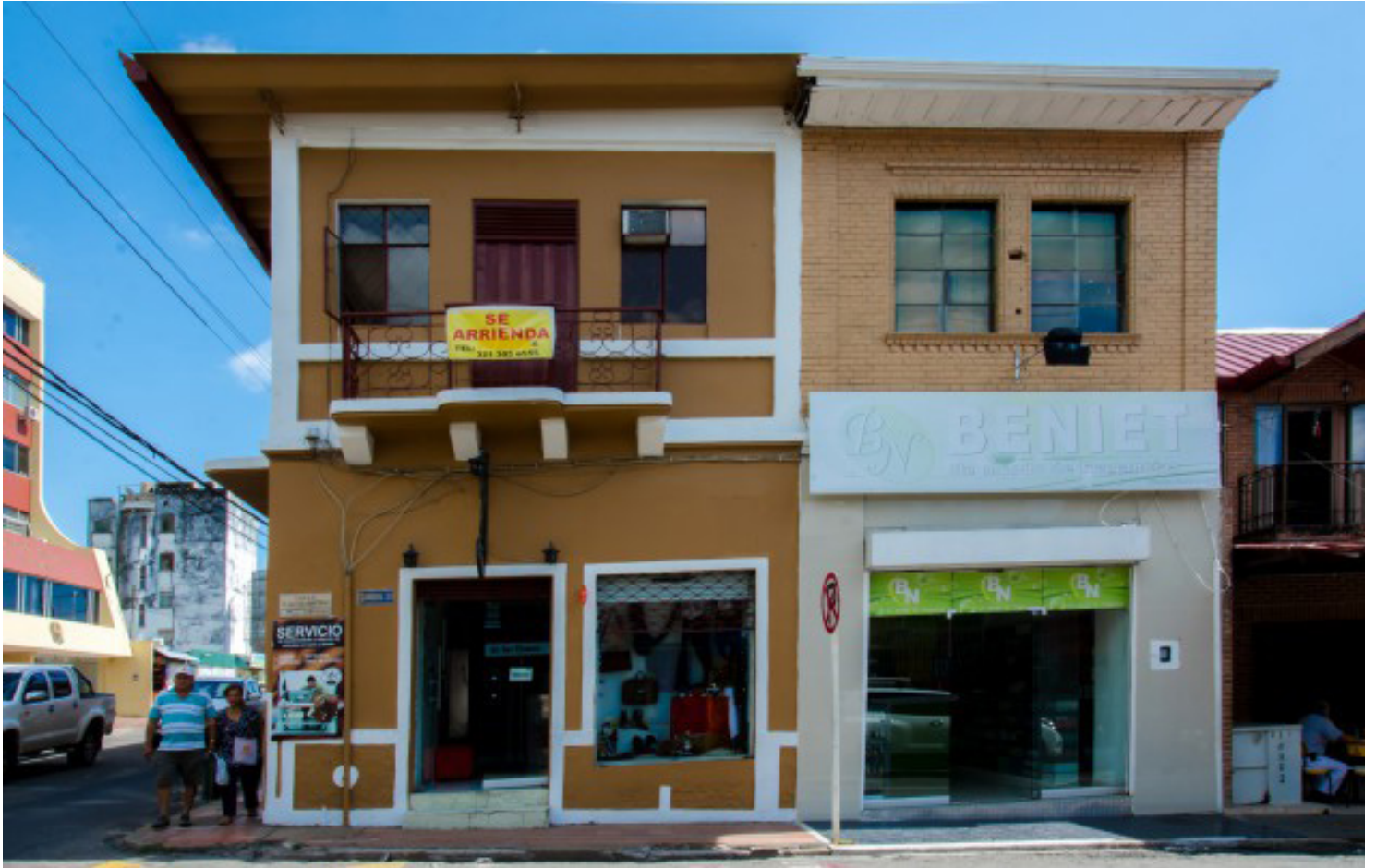
Fotografía 05: Fachada casa Santos Reina.
