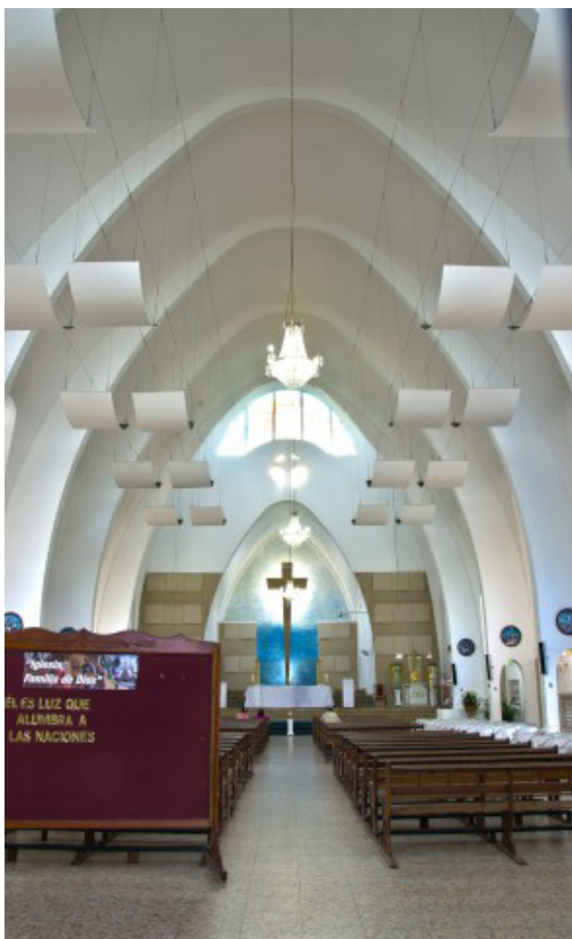
Fotografía 37: Interior, Iglesia Eucarística del Templete.
