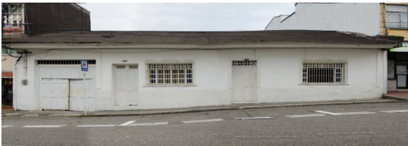
Fotografía 10: Fachada casa Señora Felicidad Barrios.
