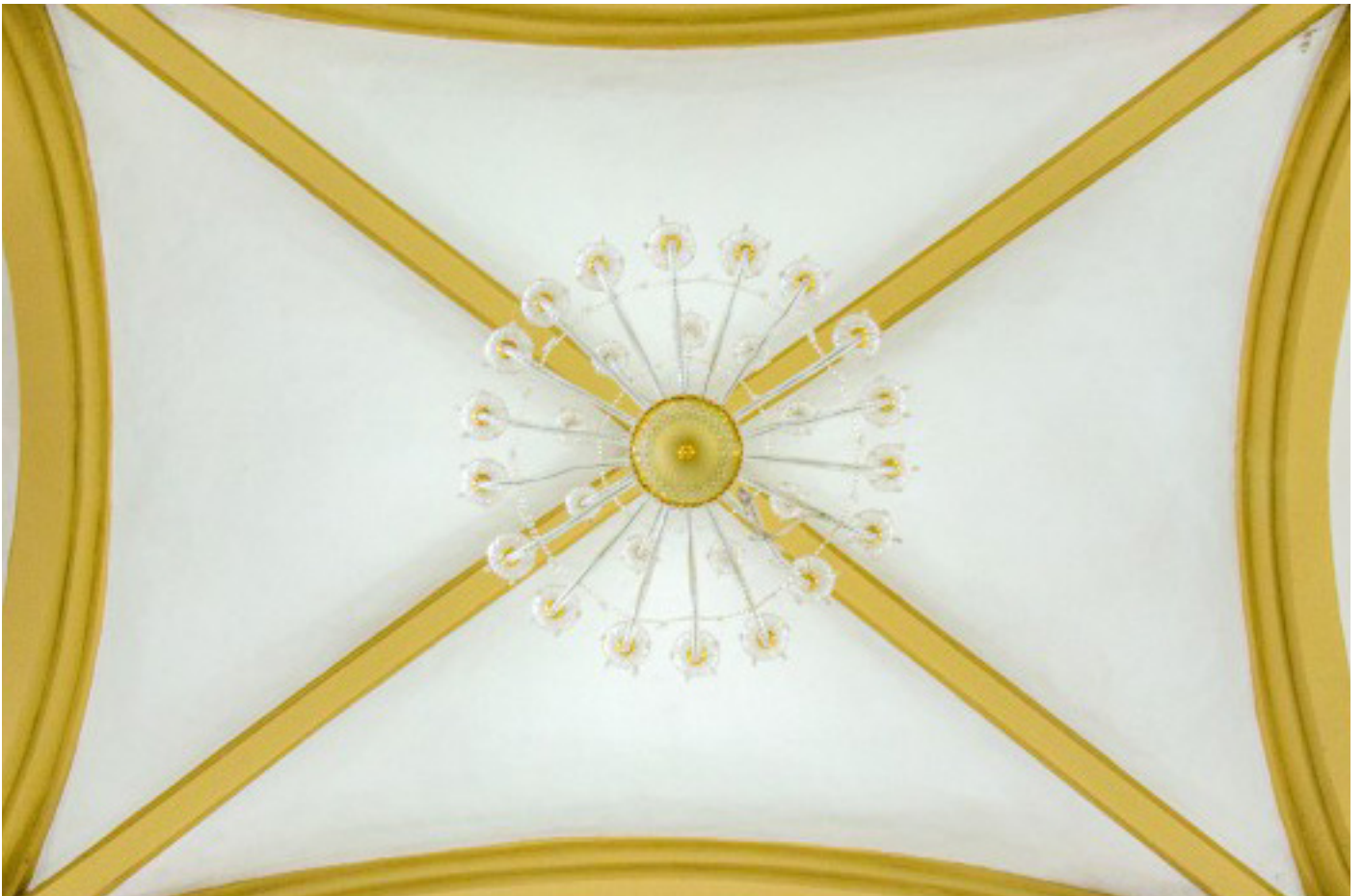
Fotografía 28: Detalle techo interior, Catedral Nuestra Señora del Carmen.
