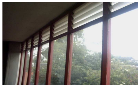
Equipos cerca a ventanas
