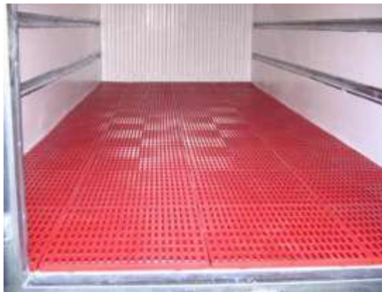
Figura 15. Piso del cuarto frío
