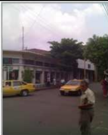
IMAGEN ESTADO ACTUAL DE LA ZONA DE ESTUDIO. Cra 10 con Calle 13 esquina costado derecho (Almacén Gilio Pascall).
