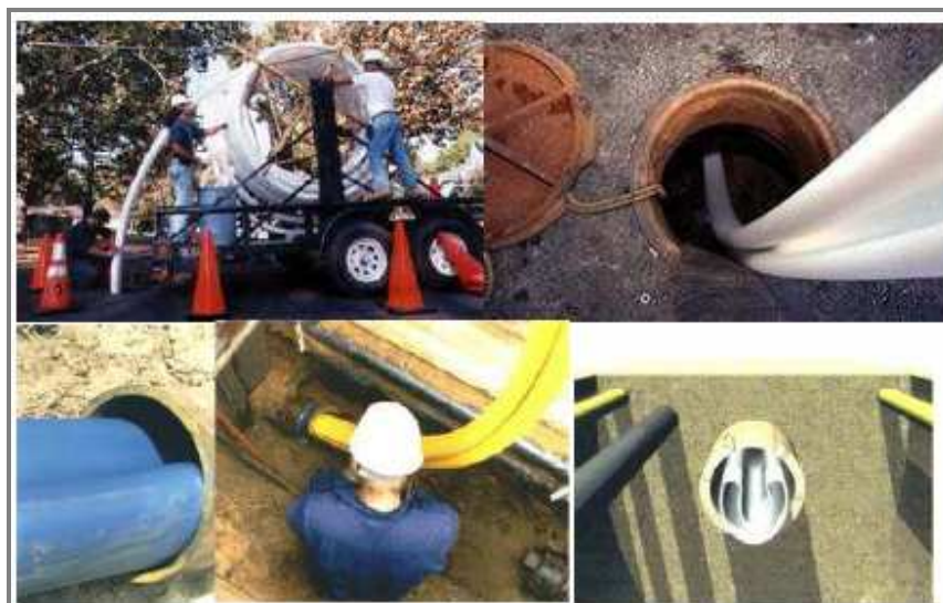
Figura 8. Entubado por deformación de PE, en forma de "U"
