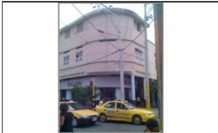
IMAGEN ESTADO ACTUAL DE LA ZONA DE ESTUDIO. Cra 10 con Calle 12 esquina costado izquierdo (Drogas la Económica).
