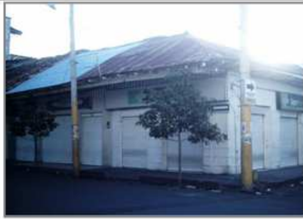
IMAGEN ESTADO ACTUAL DE LA ZONA DE ESTUDIO. Cra 10 con Calle 13 esquina costado derecho (Drogas Superfarmaj).
