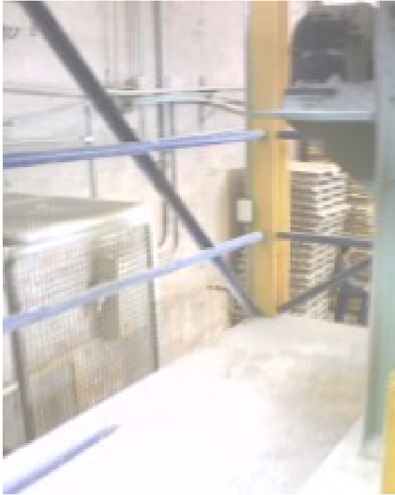
Figuras 13. 14. 15. Fotografías durante el proceso de la Instalación, cortesía pegomax s.a.
