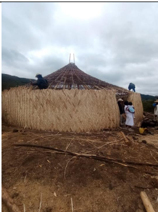
Figura 9. Casa Unguma en construcción, Ubaté
