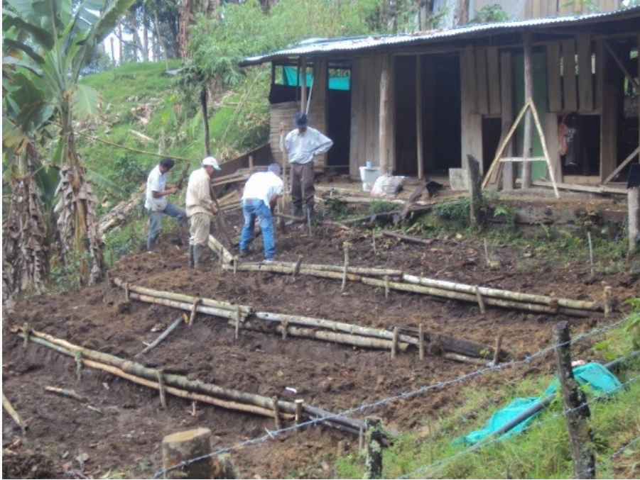
Figura 87. Construcción de casa de semillas
