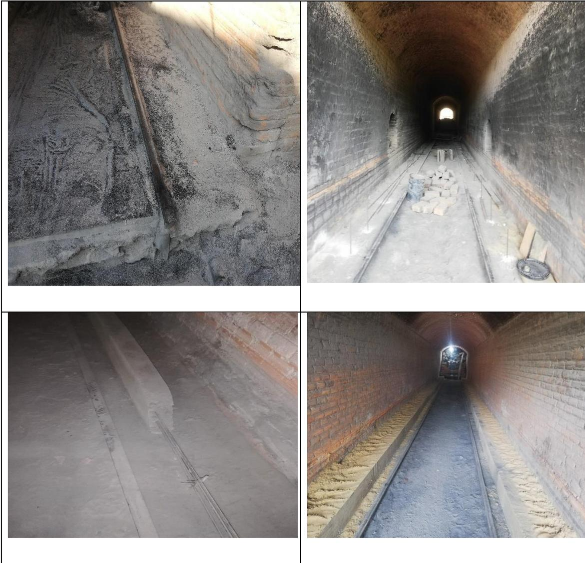
Nota: 8.Ladrillera Esparza, en la parte superior izquierda se observa el área antes de la intervenir, en la parte derecha superior se observa el alistamiento antes de fundición, en la parte inferior izquierda se divisa el proceso de fundición y finalmente la parte inferior derecha se observa el muro de contención de arena totalmente terminado y cargado listo para iniciar labores.
