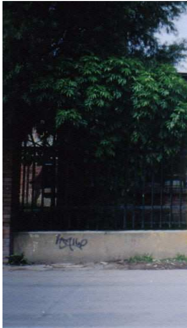
Institución Educativa Departamental Fagua, infraestructura, salida de preescolar.
