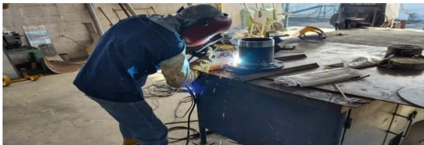
Figura 5. Soldadura real en Montajes Castaño (Fuente: Montajes Castaño)
