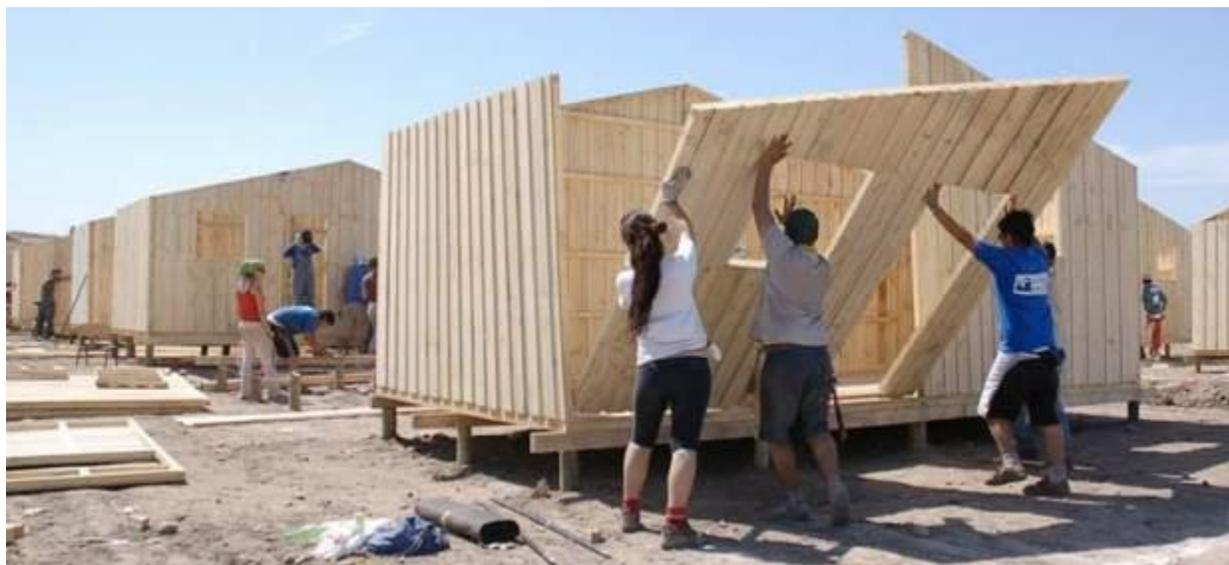
**Ilustración 6.** Modelos de vivienda Prefabricada en Madera-TECHO (2018, 2011)
