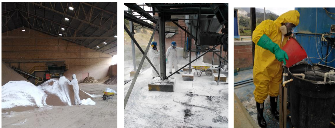
Figuras 9, 10 y 11 fase 4 Acompañamiento realización tareas con sustancias químicas.
