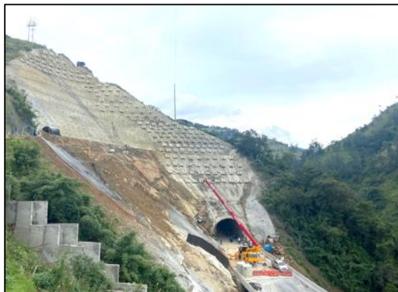
Talud Cristales K38+800 - Etapa de estabilización.
