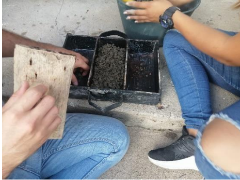
Nota. Vaciado de la mezcla en la formaleta
