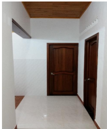
Figura 8. Terminación de adecuaciones. Elaboración Propia
