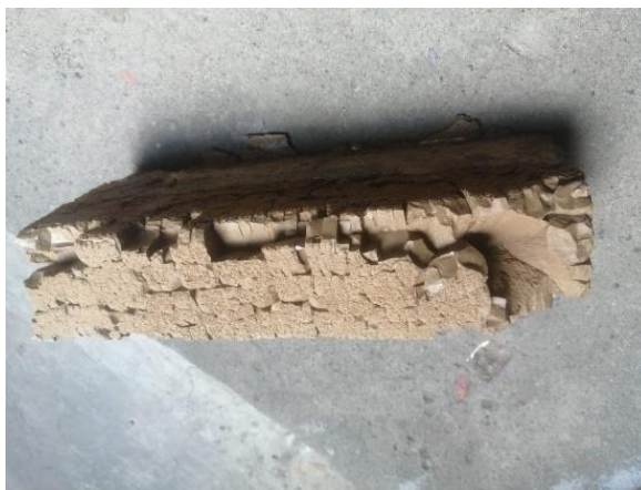
Figura 17. Ladrillo por uno de sus costados
