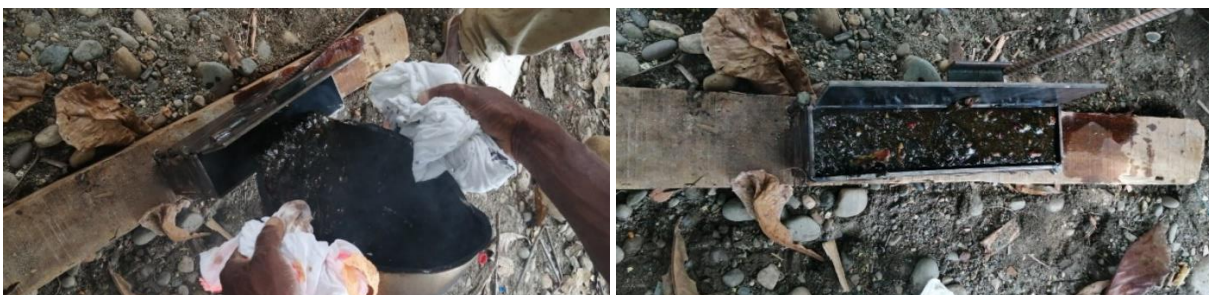
Figura 18. Aplicación del material dentro de la formaleta
