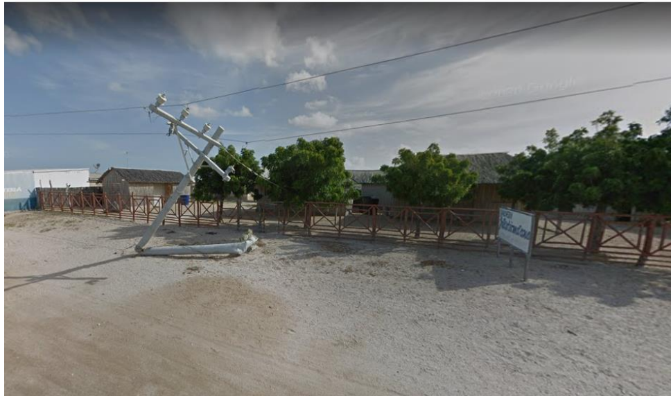
Figura 17: Red eléctrica en la guajira vandalizada
