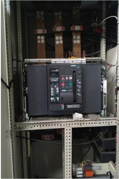
**Figura 9.** Tableros electricos señalizados, con guardas de seguridad las llaves son manejadas por el area de Mtto maquinaria.
