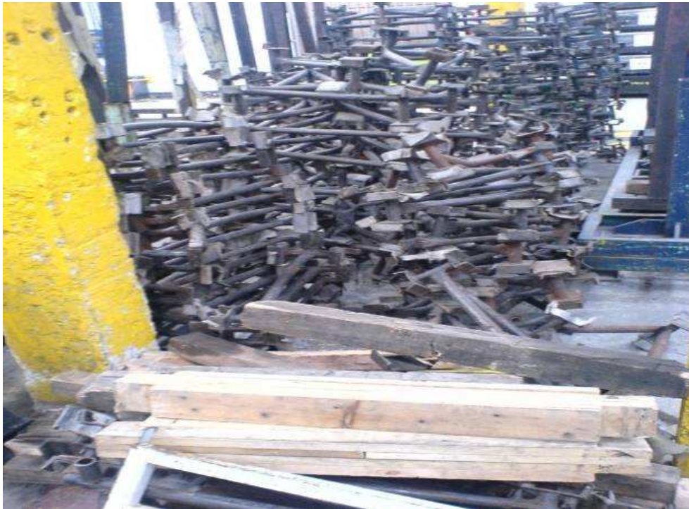
Ilustración 23. Zona de almacenamiento de dispositivos tres patas y dos patas
