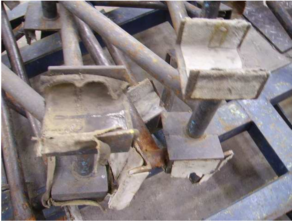
Ilustración 1. Desprendimiento de carnaza
