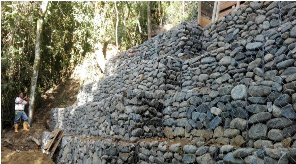
Fuente: Alcaldía de Guadalajara de Buga. 2017 – Elaboración propia. Fotografía 1: Adecuación y reparación las frías
