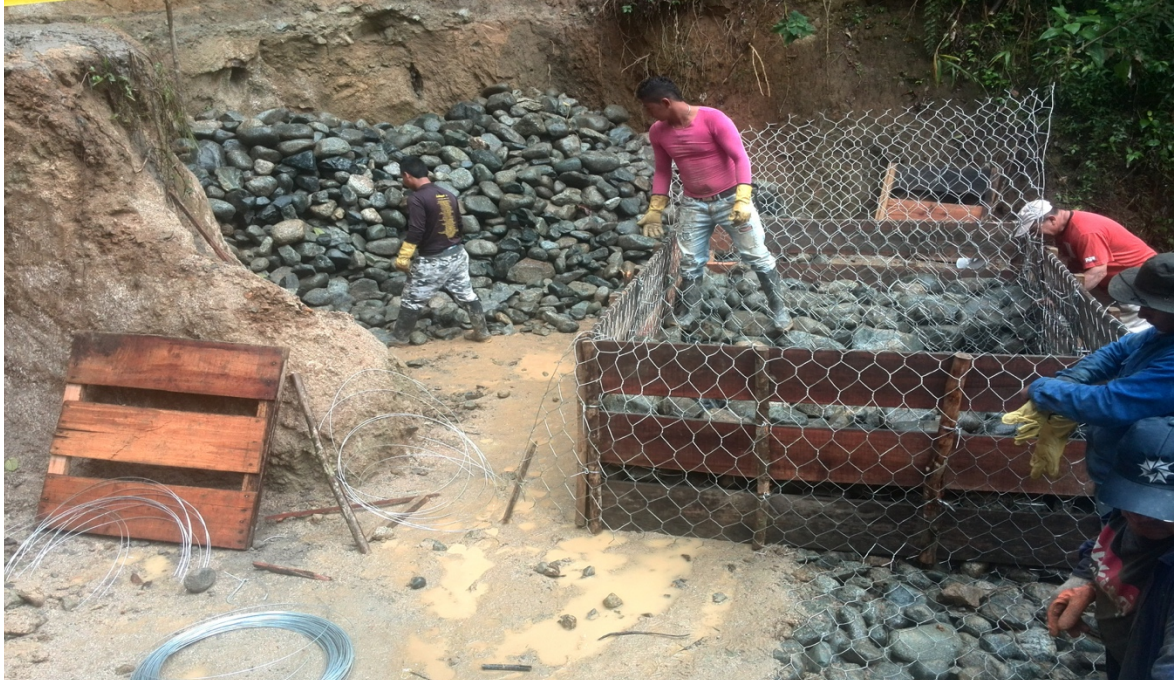
Fuente: Alcaldía de Guadalajara de Buga. 2017 – Elaboración propia. Fotografía 1: Adecuación y reparación las frías
