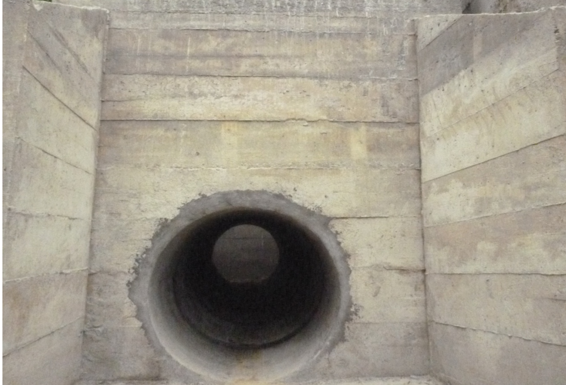
Fuente: Alcaldía de Guadalajara de Buga. 2017 – Elaboración propia. Fotografía 1: Adecuación y reparación las frías
