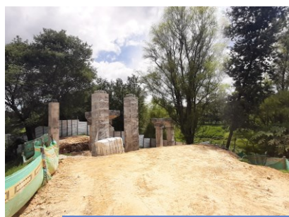
Obras del proyecto corredor
