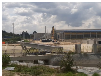
Mega obra PTAR
