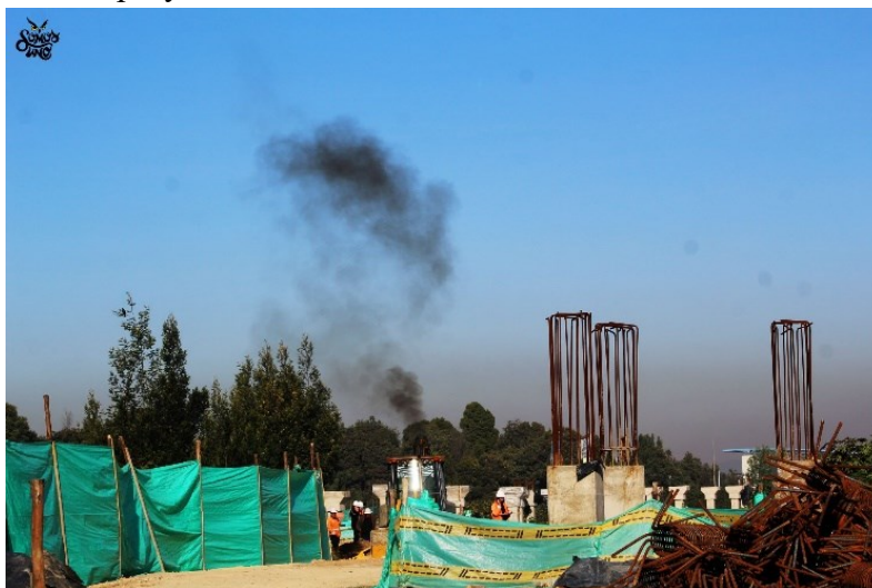
Figura 29. Obras del proyecto "Conexión Corredor Ambiental Humedal Juan Amarillo".
