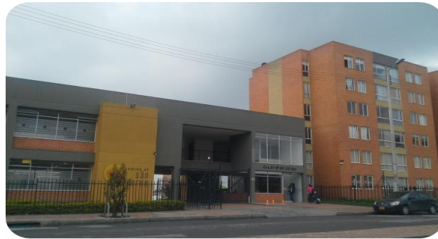
Figura 11. Fotografía proyecto San Jorge Etapa 1 y 2 Fuente: empresa GCR INGENIERAIA S.A.S, 2010
