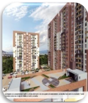
Figura 9. Fotografía proyecto Santa Elena Reservado Fuente: empresa GCR INGENIERAIA S.A.S, 2017
