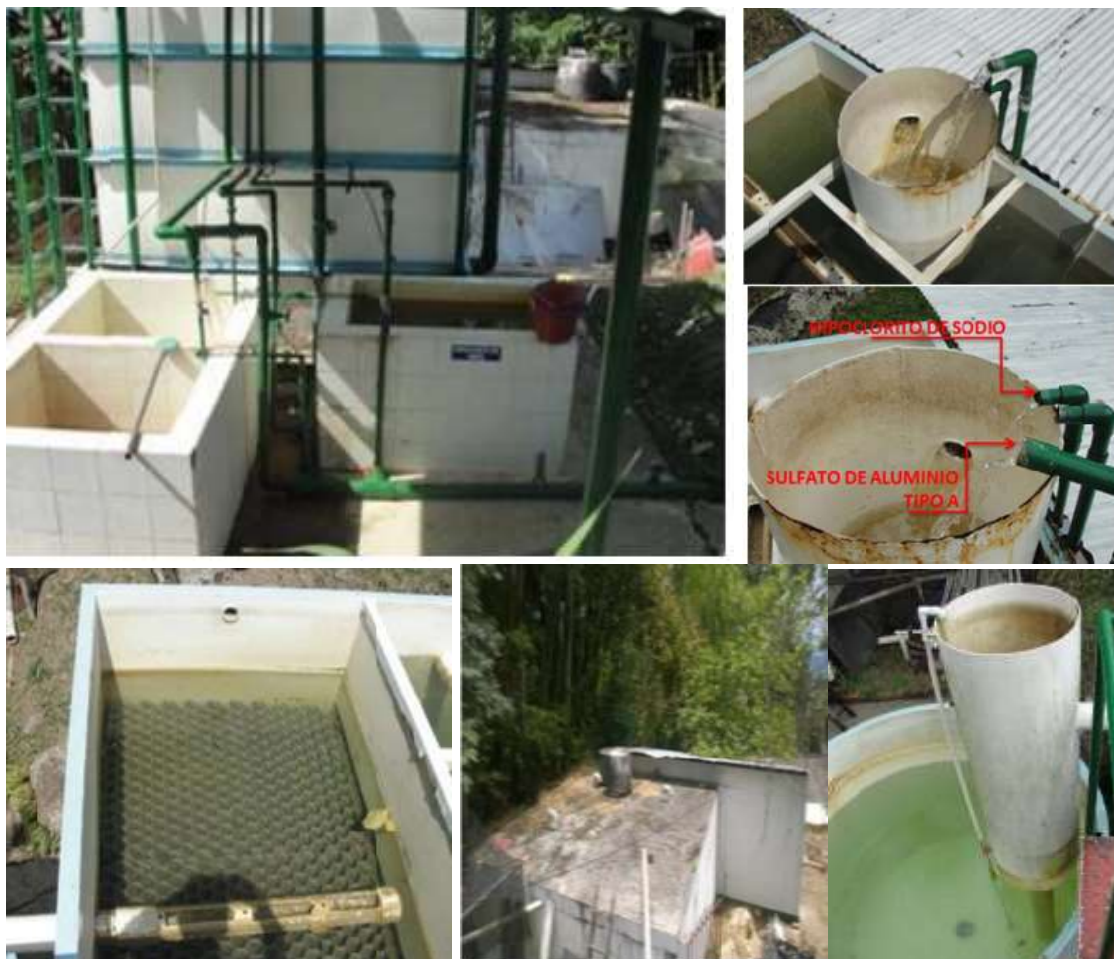
Ilustración 5. Fotografías procesos PTAP La Esperanza. [Fuente CONCORCIO PTAP LA MESA. Estudios y diseños para la optimización de la Planta de Tratamiento de Agua Potable de la inspección de la Esperanza, municipio de La Mesa Cundinamarca. 2015]
