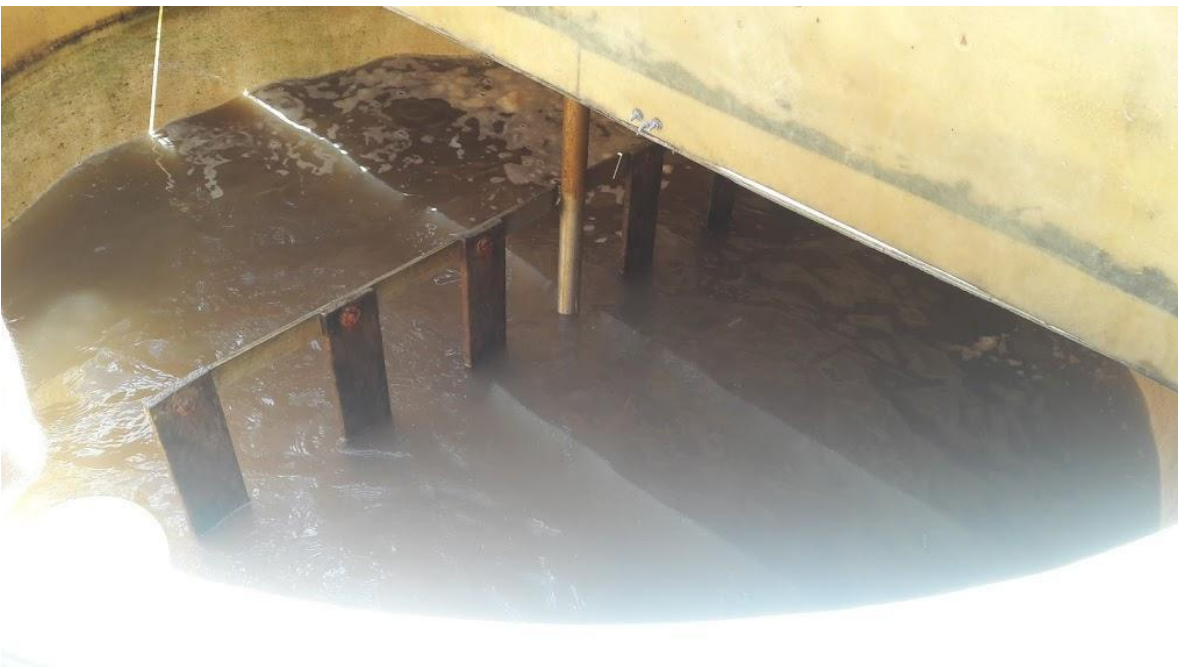
Fotografía N° 10: Reconocimineto del Tanque de Sedimentación del Acueducto El Calvario. El Santuario, Oriente Antioqueño. Fotografía de Natalia Serna Hernández, Mayo del 2018.
