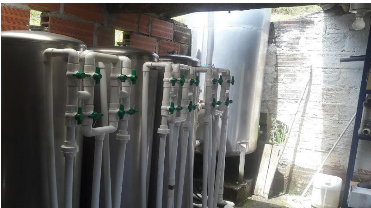
Fotografía N° 8: Reconocimiento de los tanques de Sedimentación, Filtración y Planta de Tratamiento del Acueducto La Floresta. El Santuario, Oreinte Antioqueño. Fotografía de Natalia Serna Hernández, Mayo del 2018.
