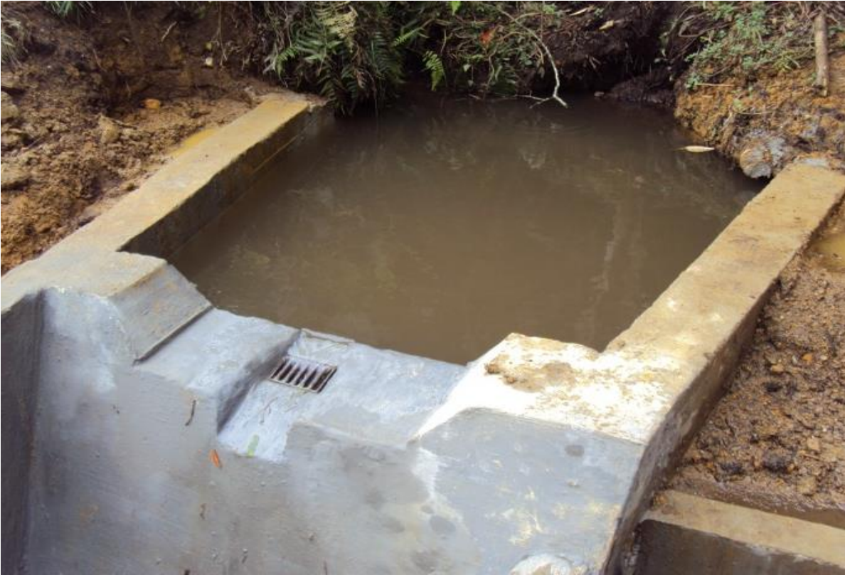
Fotografía N° 16: Reconocimiento del desarenador del Acueducto El Salto. El Santuario, Oriente Antioqueño. Fotografía tomada de ASOPROMISAN, Septiembre del 2018.
