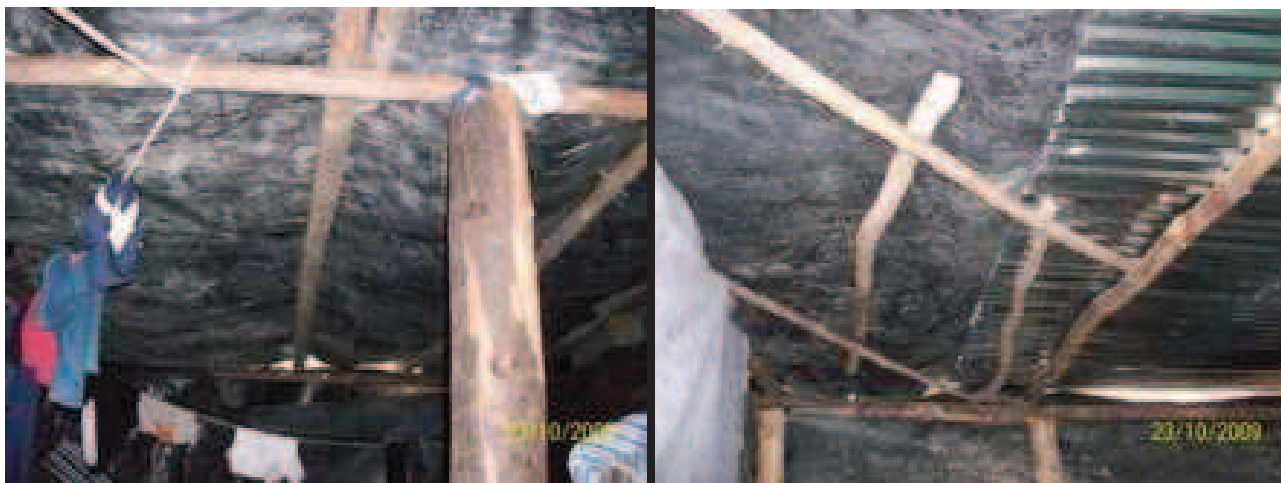
Techo al interior de la vivienda
