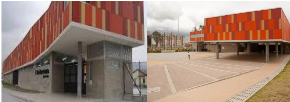
Figuras 7 y 8. Instalaciones de la institución educativa Liceo Mayor de Soacha, Fuente IE Soacha Liceo Mayor.
