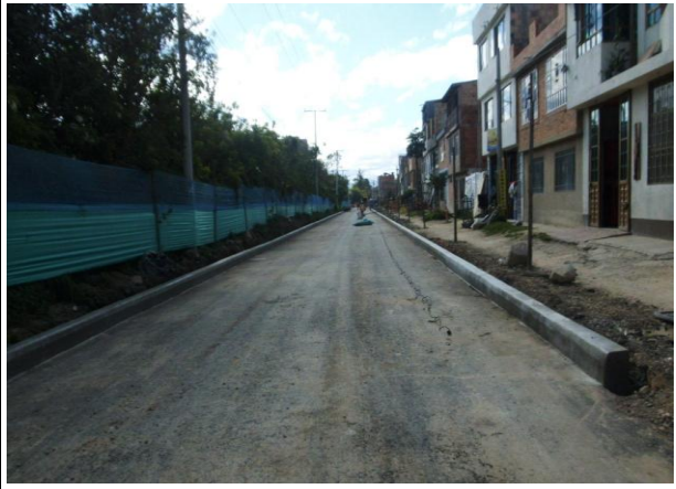
FOTOGRAFÍA N° 0001 FECHA: JORNADA DESCRIPCIÓN EL TRAMO TRES TERMINADO CON SUS BORDILLOS CORRESPONDIENTES
