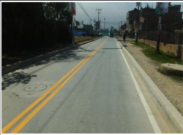
FOTOGRAFÍA N° 0005 FECHA: MAYO JORNADA DESCRIPCIÓN TRAMO DOS TOTALMENTE TERMINADO CON SU SEÑALIZACION CORRESPONDIENTE
