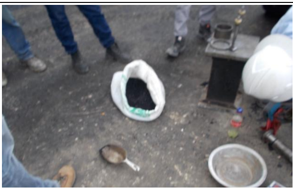
FOTOGRAFIA N° 0005 FUENTE CAMILO Y LUIS DESCRIPCIÓN PROCESO DE LUBRICACION DE LAS CAMISAS PAR SER LLENADAS DE MATERIAL DE MUESTRA EN SITIO DE OBRA
