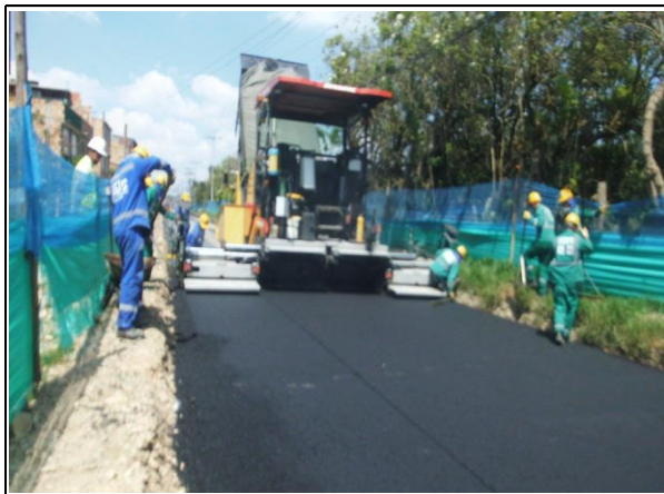
FOTOGRAFÍA N° 0005 FECHA: MAYO JORNADA DESCRIPCIÓN INSTALACION DE CARPETA ASFALTICA O MCD-2 SOBRE LA BASE COMPACTADA.
