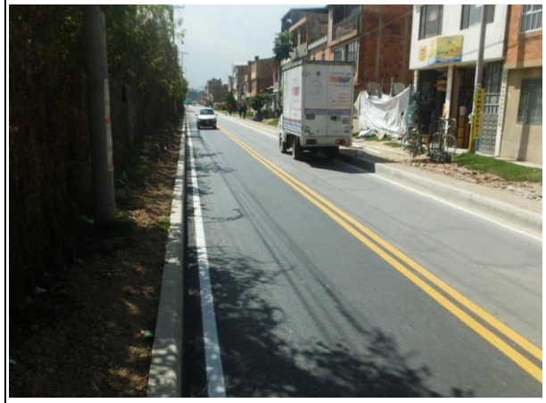
FOTOGRAFÍA N° 0004 FECHA: JORNADA DESCRIPCIÓN TRAMO TRES CON SU SEÑALIZACION HORIZONTAL Y VERIFICACION DE ZONA DE FILTROS.
