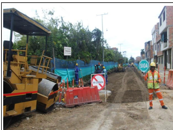
FOTOGRAFÍA N° 0003 FECHA: JORNADA DESCRIPCIÓN NIVELACION DE MATERIAL DE SUB BASE SOBRE EL RAJON
