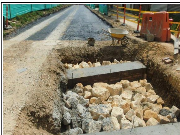
FOTOGRAFÍA N° 0002 FECHA: JORNADA DESCRIPCIÓN MEJORAMIENTO EN RAJON Y RECUBRIMIENTO EN CONCRETO DEL TUBO PLASTICO PARA SISTEMA DE SUMIDEROS
