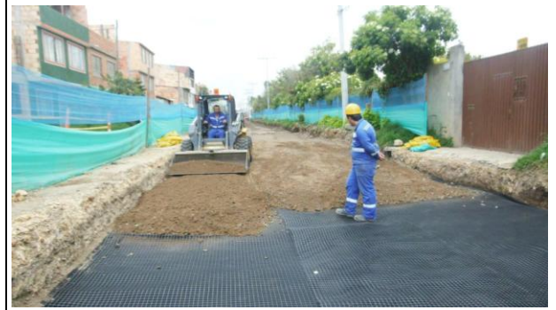
FOTOGRAFÍA N° 0002 FECHA: JORNADA DESCRIPCIÓN INICIO DE NIVELACION DEL MATERIAL SOBRE LA MAYA QUE SEPARA LA SUB BASE Y LA BASE.
