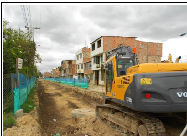
FOTOGRAFÍA N° 0001 FECHA: JORNADA DESCRIPCIÓN EXCAVACION MECANICA EN UNA PROFUNDIDAD DE 0.90 MTS
