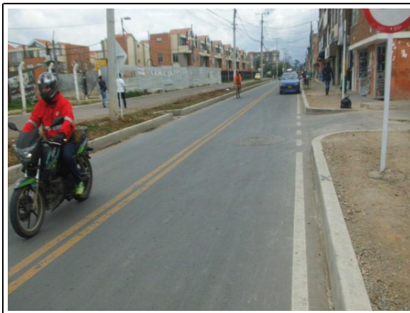
FOTOGRAFÍA N° 0006 FECHA: MAYO JORNADA DESCRIPCIÓN TRAMO TERMINADO TOTALMENTE CON SU SEÑALIZACION Y DE RESALTOS EN LA BOCA CALLE
