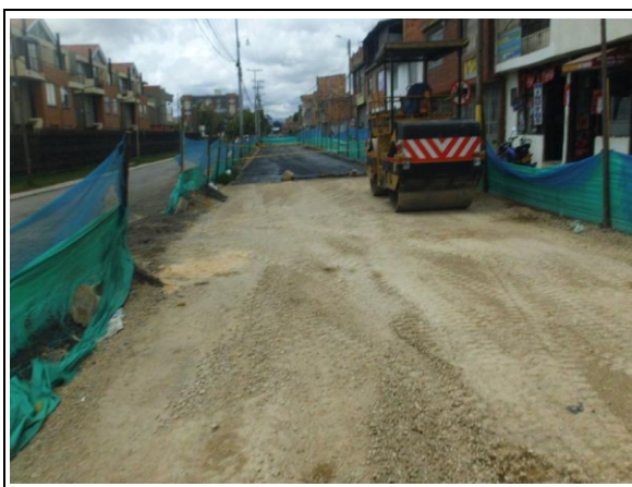
FOTOGRAFÍA N° 0004 FECHA: JORNADA DESCRIPCIÓN COMPACTACION DEL MATERIAL GRANULAR PARA LA BASE E IMPRIMACION DE EMULSION ASFALTICA
