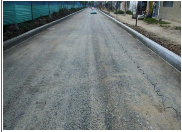
FOTOGRAFÍA N° 0002 FECHA: JORNADA DESCRIPCIÓN CARPETA RODADURA TERMINADA, INSPECCION DE LA CARPETA
