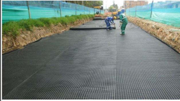
FOTOGRAFÍA N° 0001 FECHA: JORNADA DESCRIPCIÓN CONFORMACION E INSTALACION DE LA MAYA BIOAXIAL SOBRE LA SUB BASE
