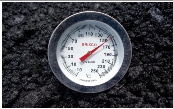
FOTOGRAFIA N° 0001 FUENTE LUIS Y CAMILO DESCRIPCIÓN SE TOMA REGISTRO DE LA TEMPERATURA CON TERMOMETRO A LA MEZCLA ASFALTICA DE LLEGADA AL SITIO DE LA OBRA
