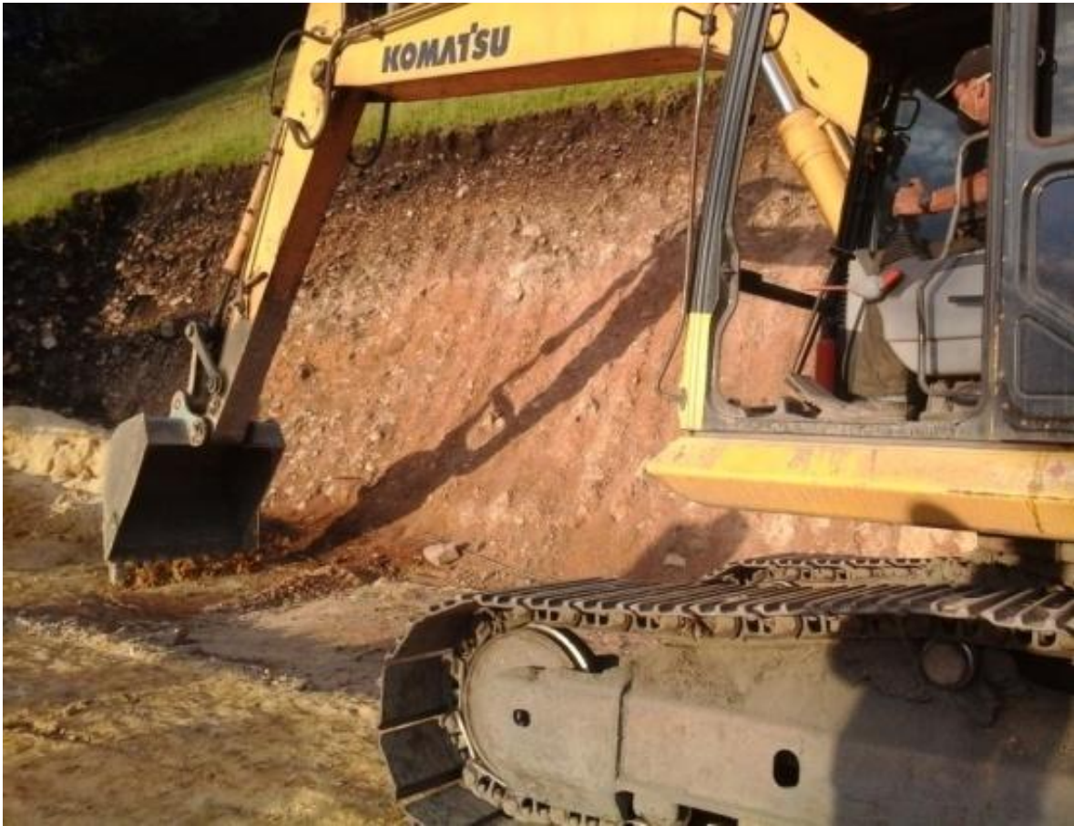
Fotografías excavación terreno W-E
