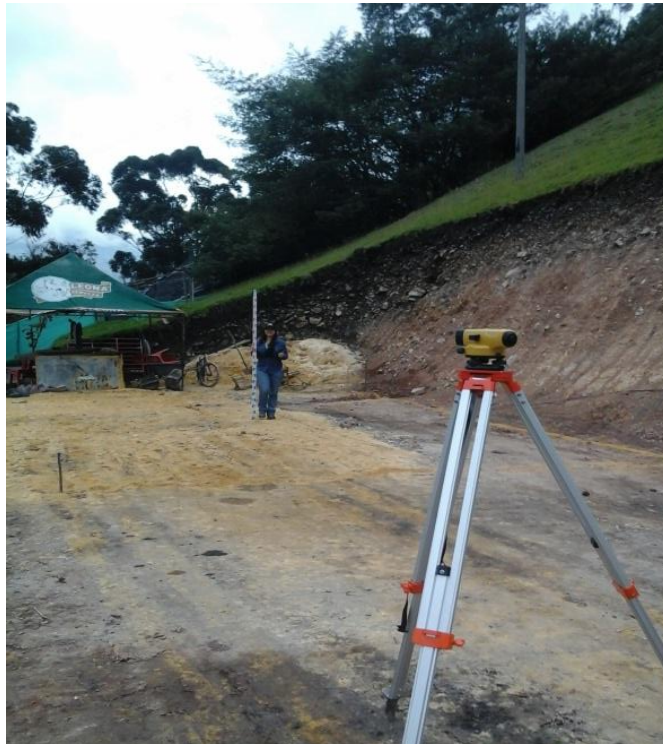
Fotografía levantamiento topográfico W-E
