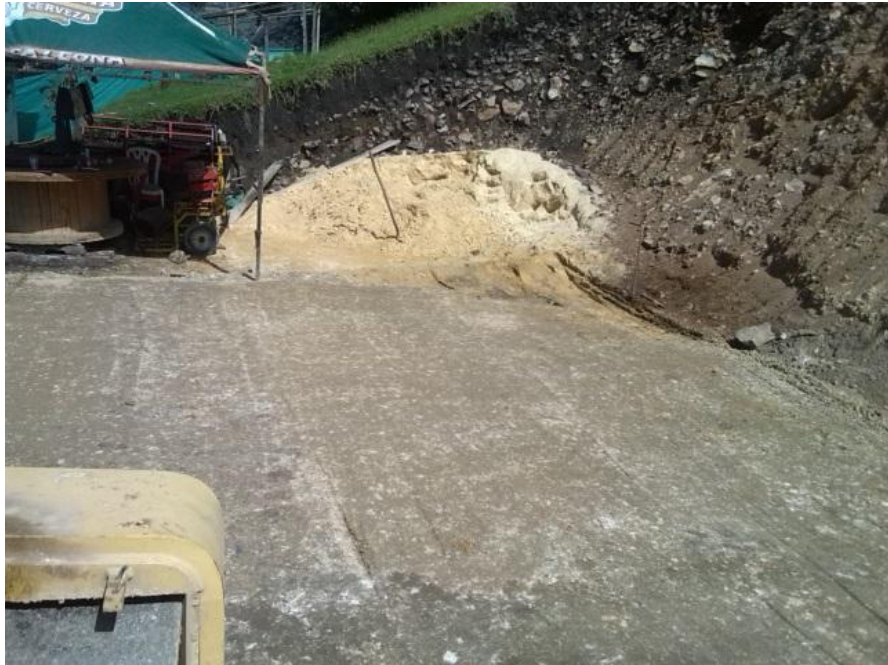
Fotografía compactación cilindro W-E
