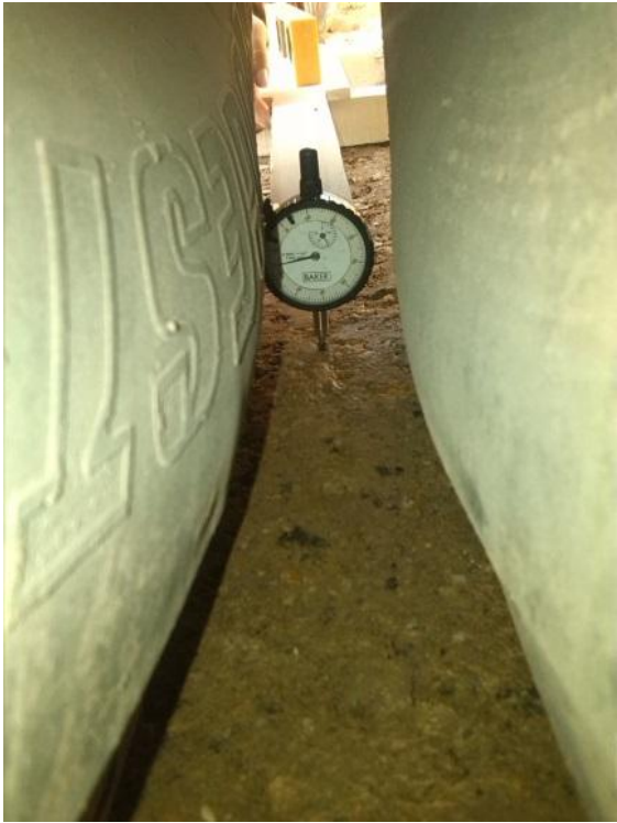
Fotografía caratula W-E tramo sin geomalla
