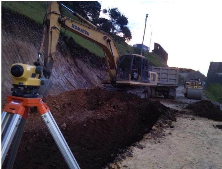
Fotografías excavación E-W
