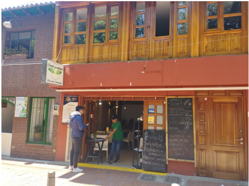
Autoría Propia. Fachada del Restaurante Mangos
