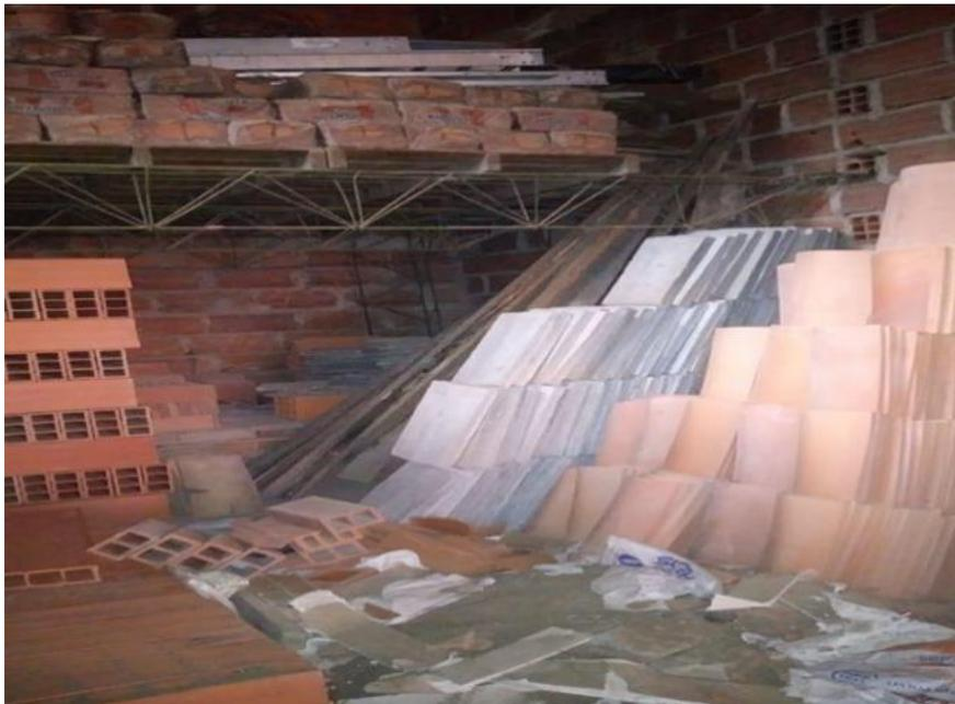
*Figura 3 Almacenamiento de ladrillos y tejas bodega 2 se puede observar basura, la desorganización al momento del almacenamiento de los ladrillos están mezclados.*
