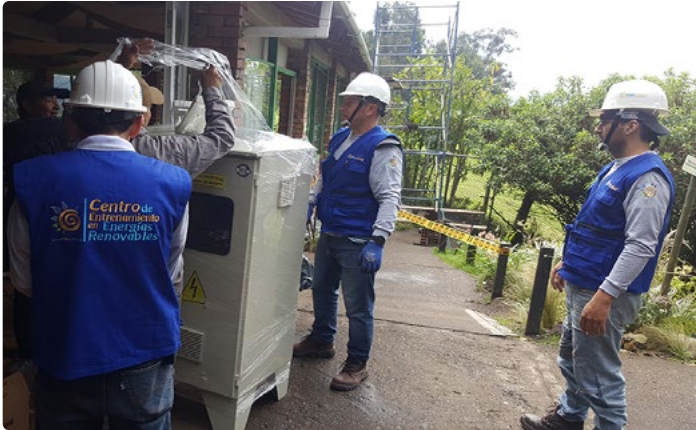
Figura 10. Logística de instalación del sistema solar fotovoltaico
