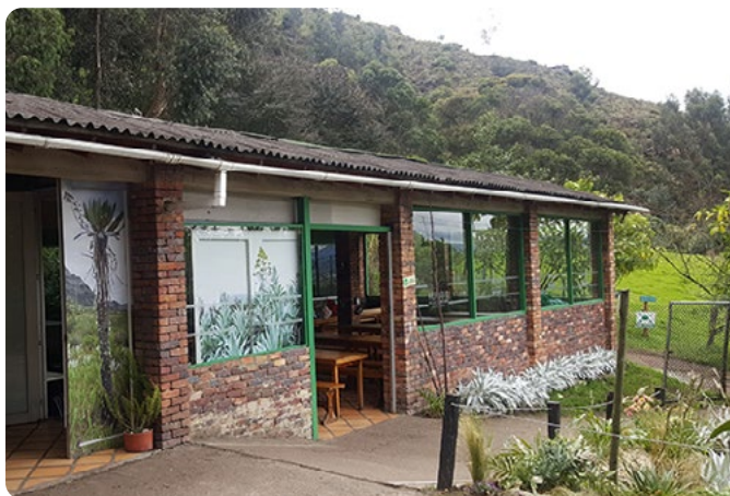
Figura 8. Lugar seleccionado para la instalación del sistema solar fotovoltaico
