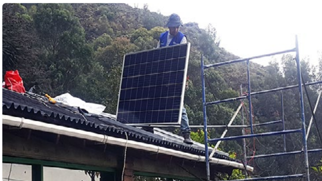
Figura 14. Trabajo en alturas y ascenso de los paneles
