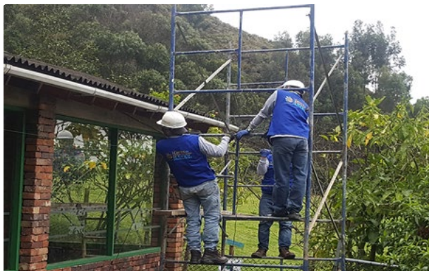
Figura 12. Revisión de la cubierta para ubicar los paneles solares
