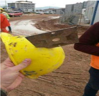
A la penetración
