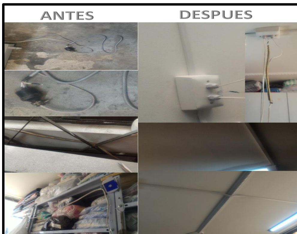
Figura A Antes y después adecuación cableado eléctrico. Tomado de “ENANOS SPORT JH.”
