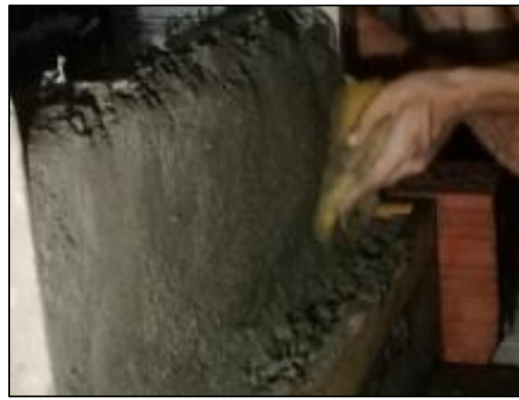
Ilustración 54. Pañete de muros.
