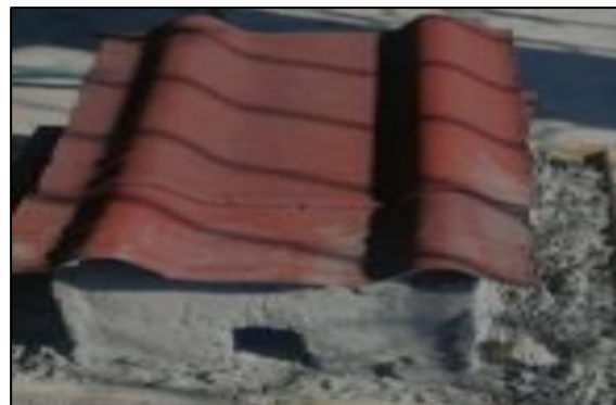
Ilustración 55. Terminación de cubierta convencional.
