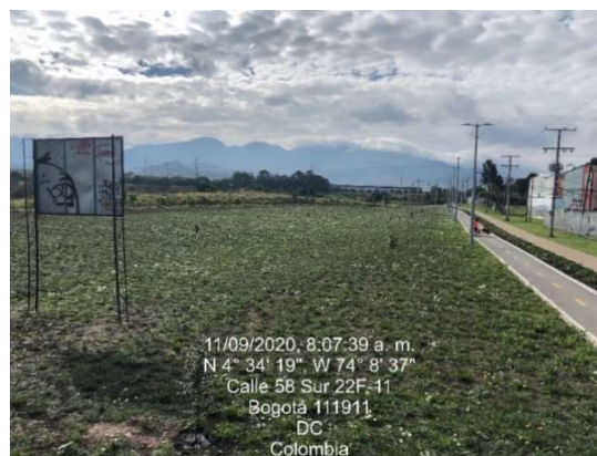
Ilustración 3. Construcción ciclo ruta, sendero peatonal y siembra de coberturas
