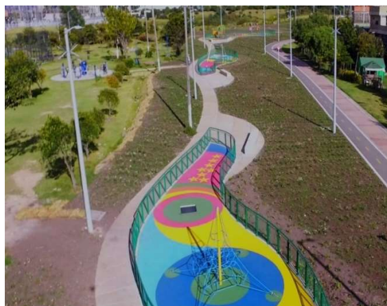
Ilustración 11. Estado posterior a la intervención
