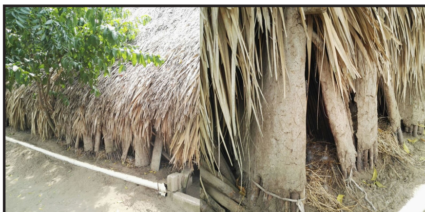
FIGURA 6.3. Ponedero bajo techo de palma y cubierta de bahareque, sobre el piso. Fuente: Los autores.
