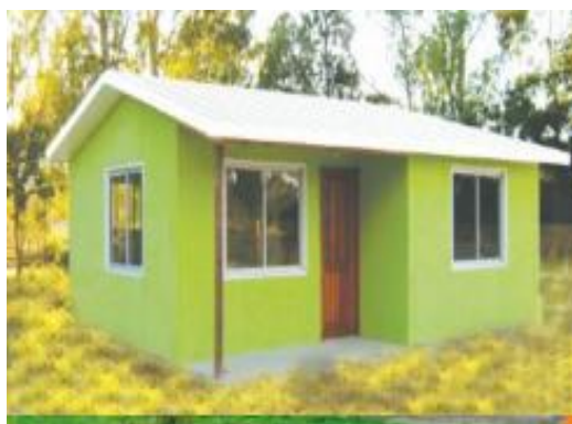
Ilustración 17 Vivienda Prefabricada terminada
