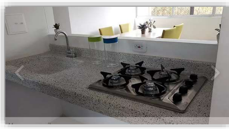
Imagen 7. Mesón en granito fuente: (R&A Construcabados, 2020)
