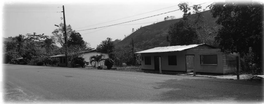
Fotografía 16. Foto con intervención Calle abandonada de un municipio del Bajo Cauca Antioqueño Título: Lo que deja la violencia.
