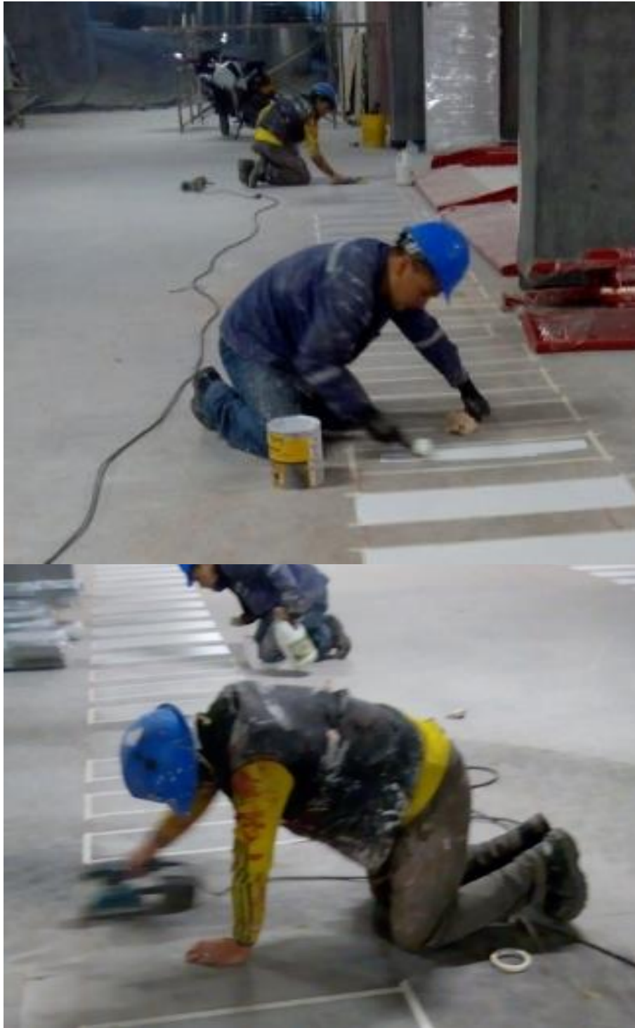
Proceso productivo: señalización con pintura trafico VIRGILIO SABOYA S.A.S
