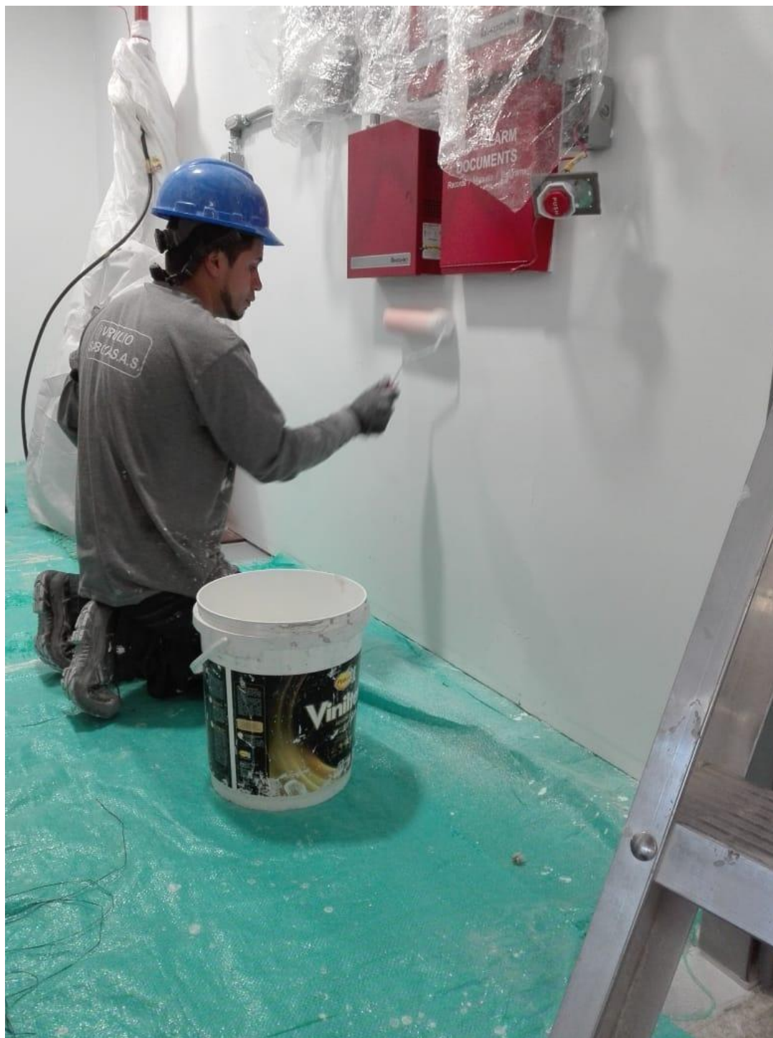
Proceso productivo: corte e instalación de laminas y pintura de muro en fachada VIRGILIO SABOYA S.A.S
