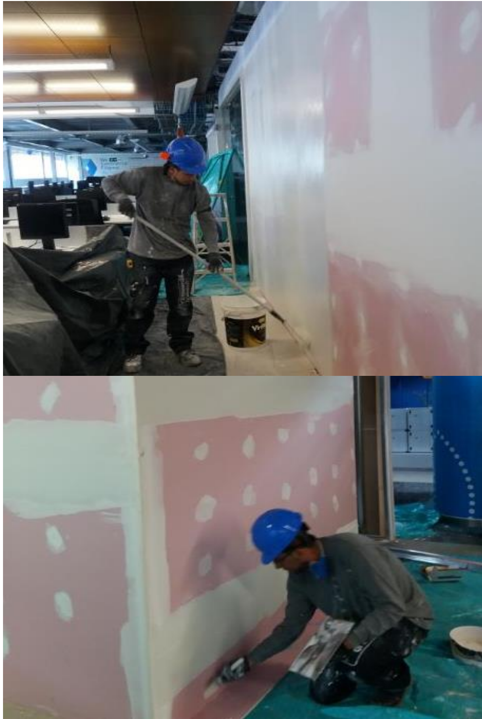
Proceso productivo: masillado y pintura muros VIRGILIO SABOYA S.A.S.
