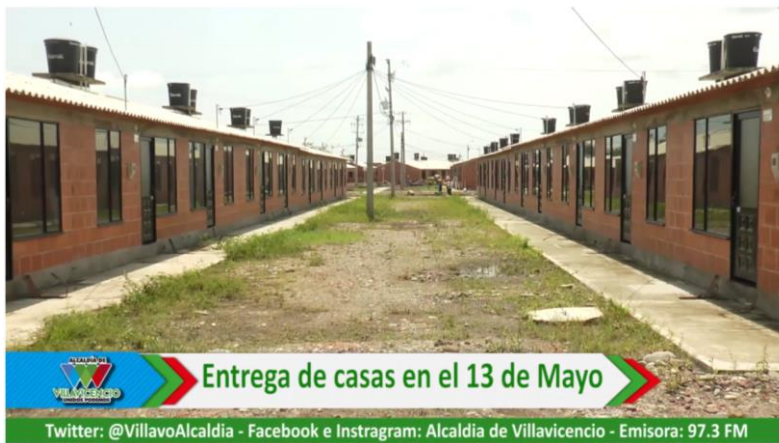
Imagen 6: fotografía de las viviendas construidas por la alcaldía para habitantes del barrio 13 de mayo.
