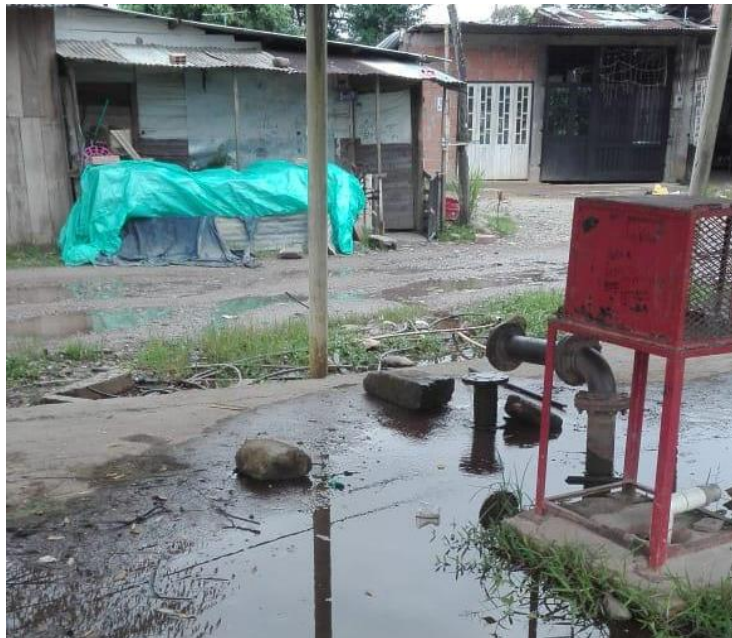
Imagen 10. Fotografía de Antigua Pileta de Agua, reemplazada por sistema de acueducto y alcantarillado
