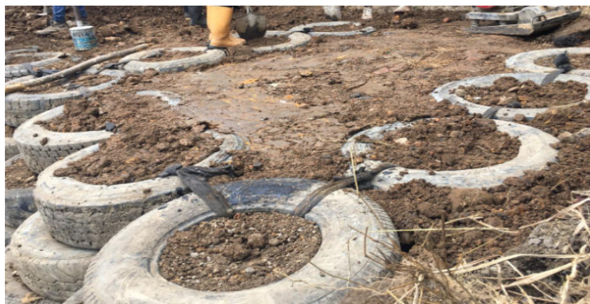
Figura 35. Detalle en situ de amarre y cimentación de los neumáticos
