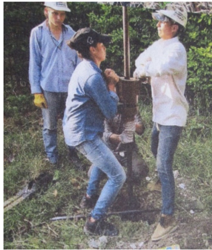
Figura 9. Estudio de suelos por medio de equipo de penetración (SPT)
