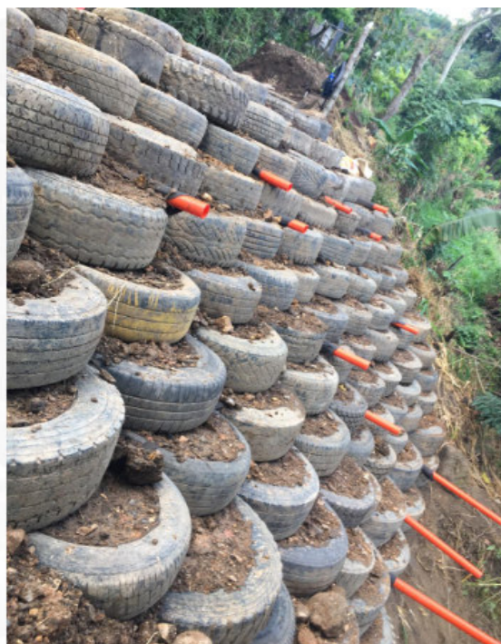
Figura 40. Filtros instalados en el muro
