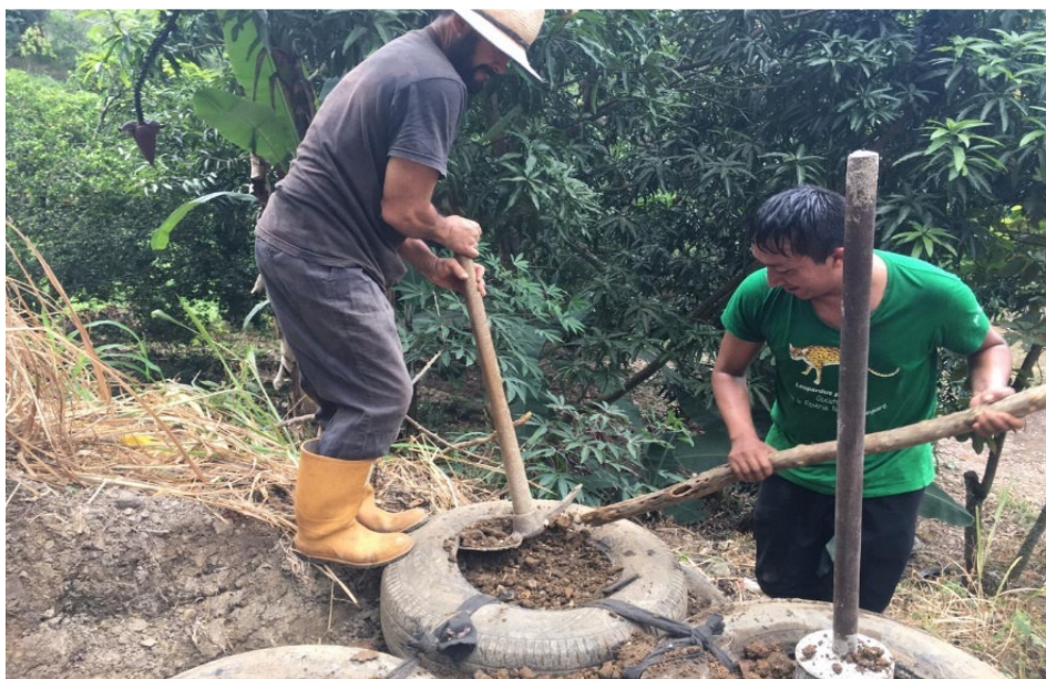
Figura 37. Relleno y compactación en situ, de los neumáticos
