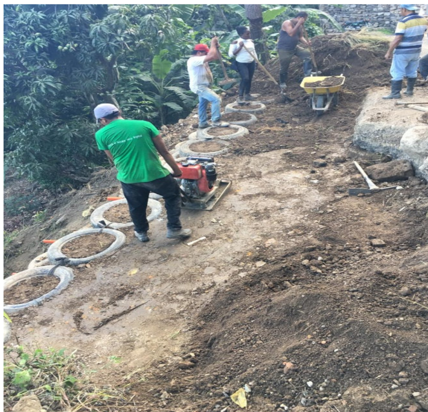
Figura 38. Nivelación del terreno, con equipo neumático,
