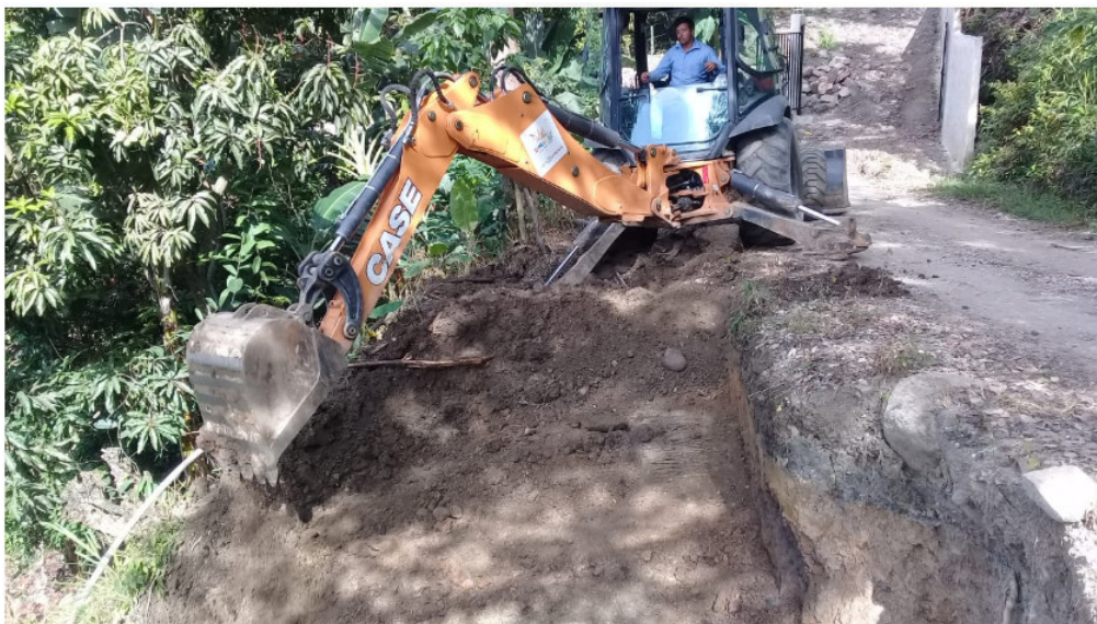
Figura 32. Descapote y limpieza del terreno
