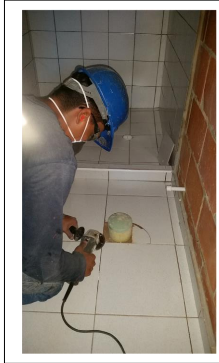
17 inspección de área de trabajo
