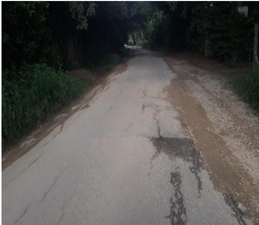
Ilustración 14 Ahuellamineto
