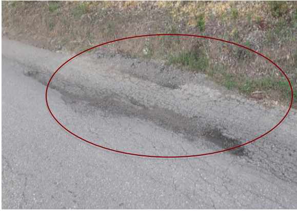
Ilustración 11 Hundimiento
